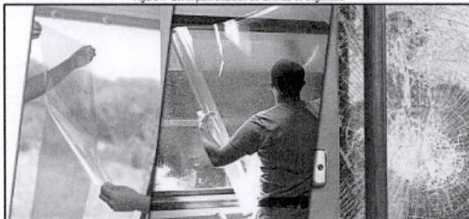
Figura n° 26: Implementación de láminas de seguridad
