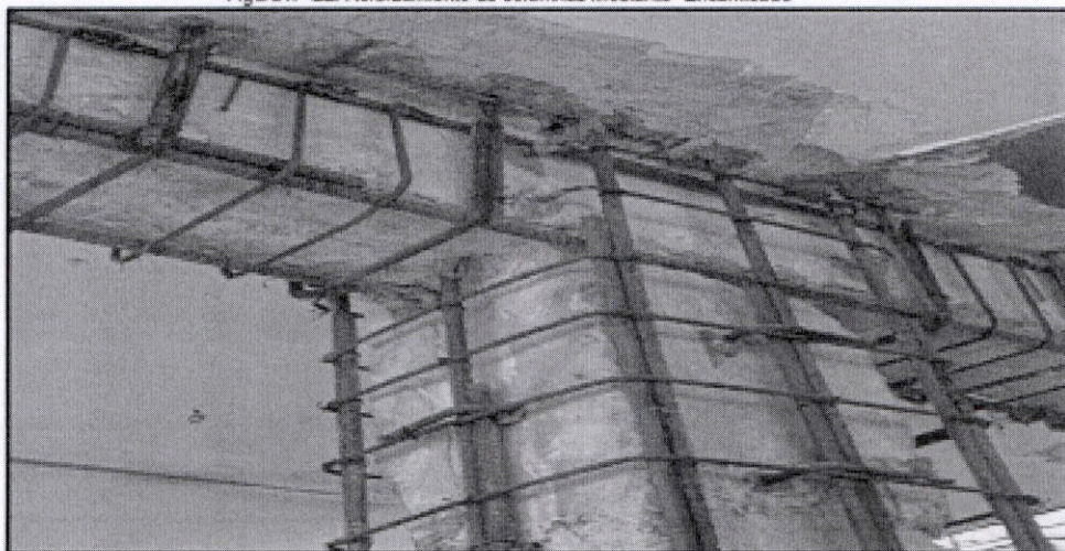
Figura n° 22: Reforzamiento de columnas mediante "Encamisado"
