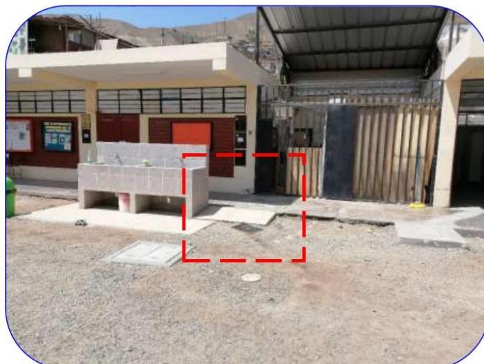
Fotografía N°04.- Vista de rampa temporal con pendiente pronunciada
