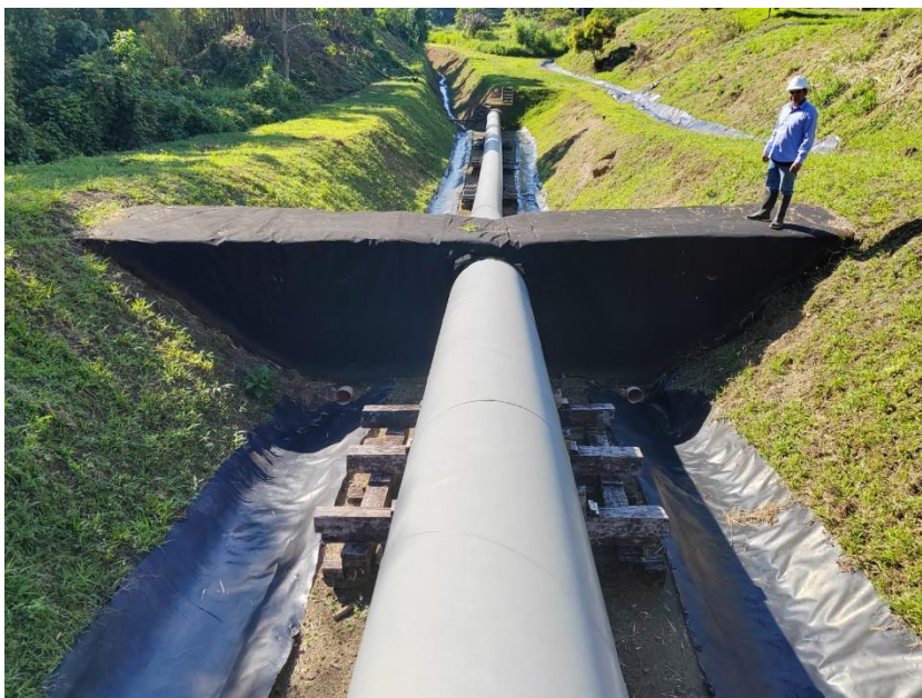
Gráfico N°7 – Anillo de protección terminado.
