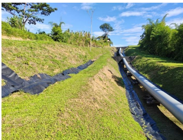
Gráfico N° 10.- Instalación de Geomembrana sobre cunetas
