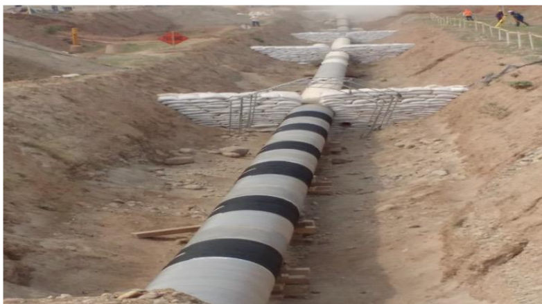
Gráfico N°6 – Anillo de protección terminado.
