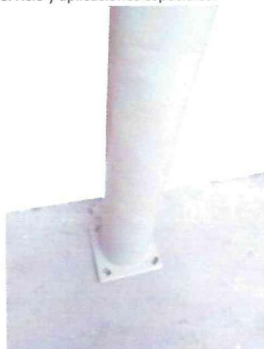
Poste con base o Embone con la instalación sobre la superficie (brida revestida en PRFV para protección a la corrosión y a agentes químicos)
