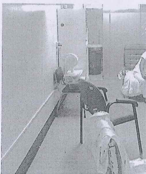
Imagen 14: Los muros interiores de los ambientes anexos de la sala de hospitalización B2 no cuentan con contrazócalo sanitario y zócalo a una altura no menor a 1.50 m, sobre el contrazócalo sanitario.
