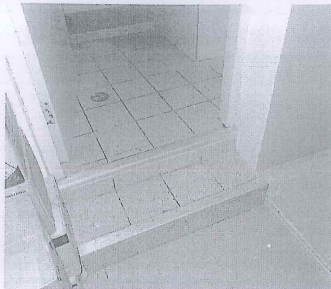
Imagen 13: Se requiere eliminar los desniveles, pasos y poyos de concreto.
