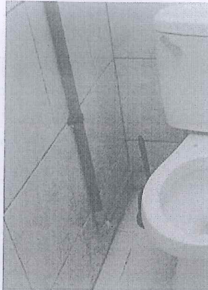
Imagen 05: Tuberías de agua expuestas (no empotradas)
