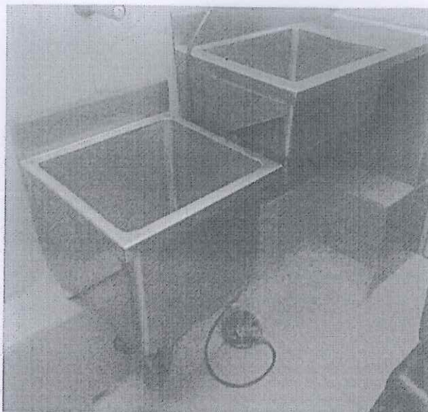
Imagen 09: La pendiente de la red no es la adecuada, se han generado poyos de diferentes alturas para alojar las tuberías de desagüe; lo cual no permite contar con una superficie uniforme (dificulta la limpieza y genera acumulación de polvo)
