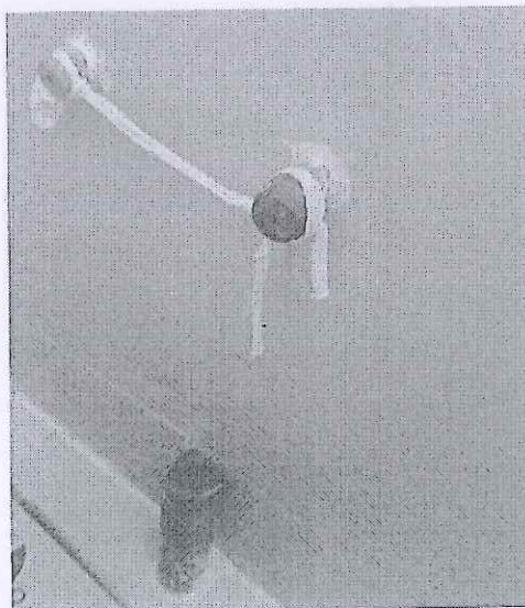
Imagen 04: Puntos de agua y desagüe no anulados adecuadamente
