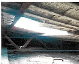
FOTO N°01 se observa el mal estado de la cobertura de UPSS Hospitalización.
