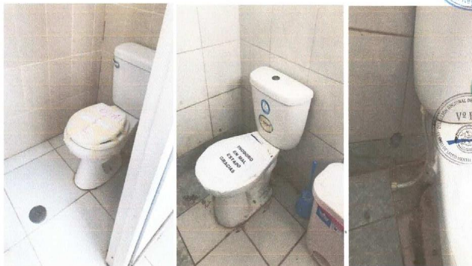
SS.HH EN MAL ESTADO, SIN FUNCIONAMIENTO
