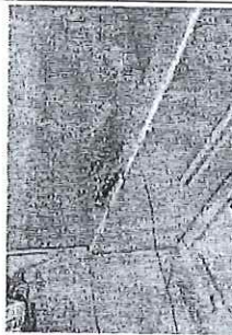
Foto N° 03: Cielo raso de drywall en mal estado, humedecido con presencia de hongo.
