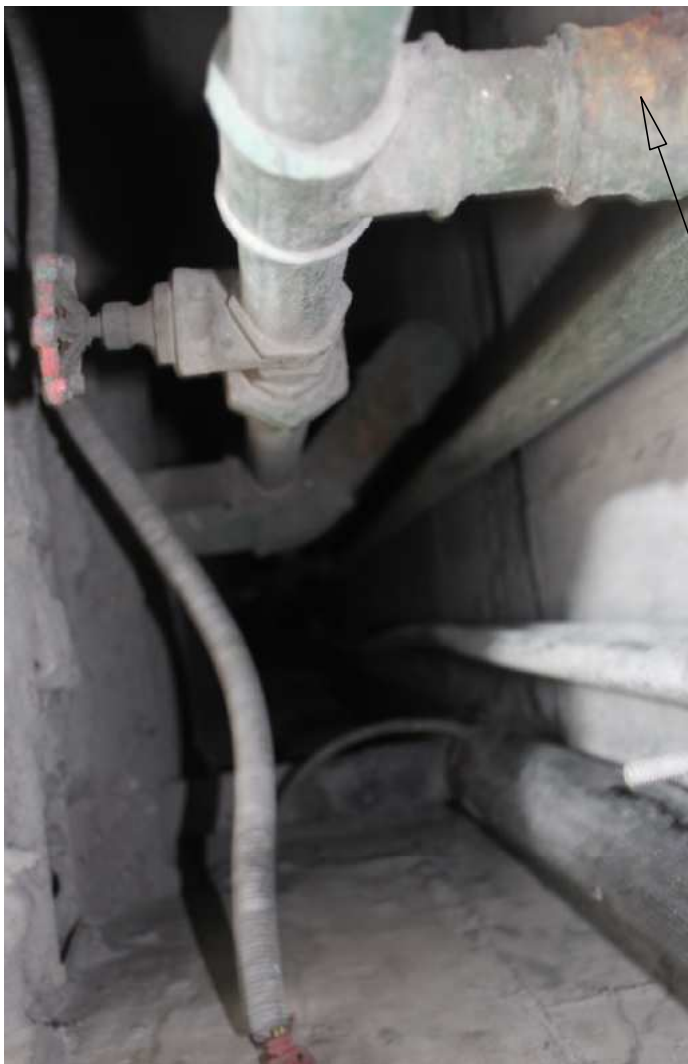
TRAMO EN FIERRO GALVANIZADO, PRESENCIA DE CORROSION
