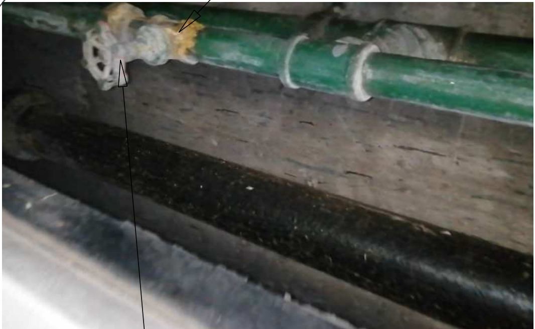
VALVULA DE CONTROL EN MAL ESTADO
