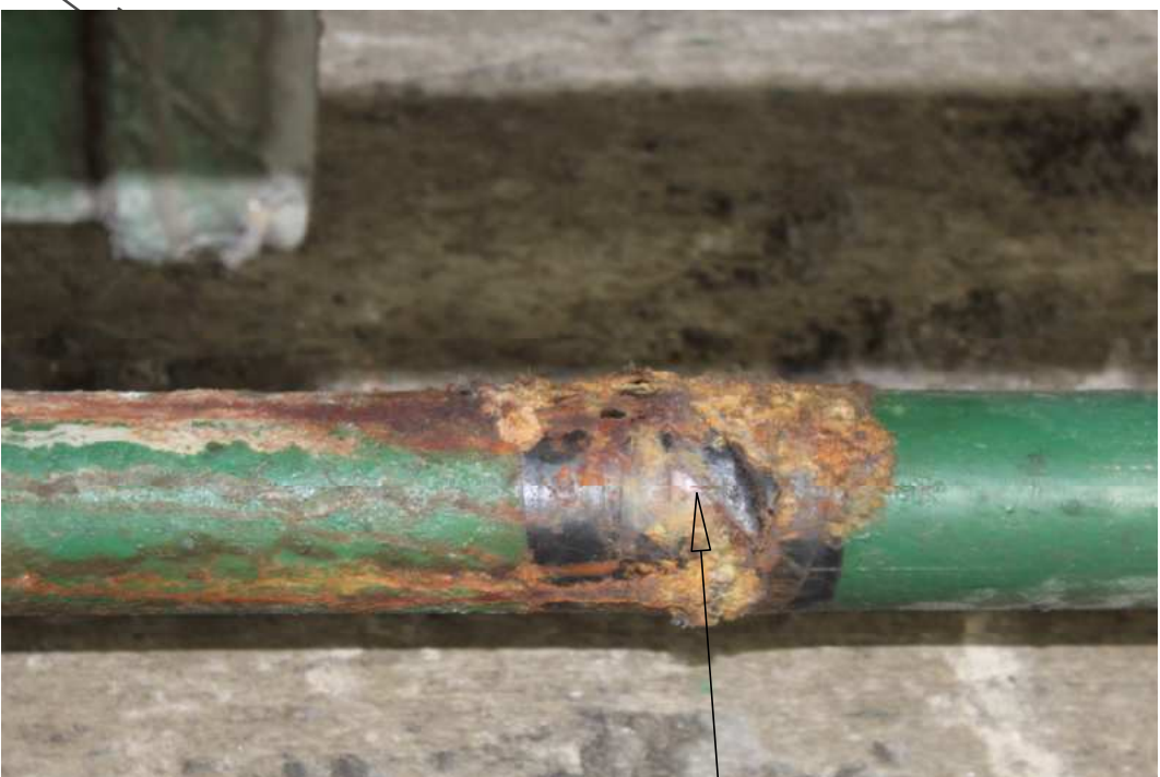
VALVULA DE CONTROL EN MAL ESTADO
