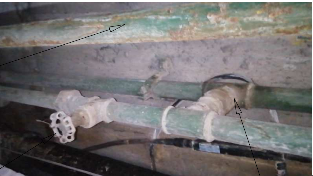
VALVULA DE CONTROL EN MAL ESTADO TRAMO EN FIERRO GALVANIZADO, PRESENCIA DE CORROSION
