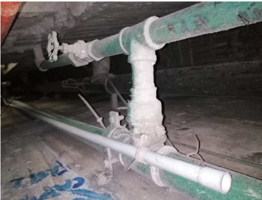
VALVULA DE CONTROL EN MAL ESTADO
