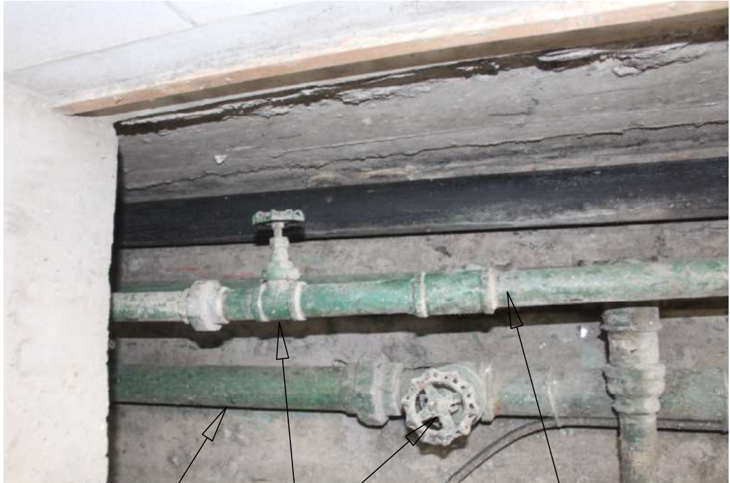
TRAMO REPARADO CON CHADERA DE PVC TRAMO EN FIERRO GALVANIZADO VALVULA DE CONTROL EN MAL ESTADO TRAMO EN FIERRO GALVANIZADO
