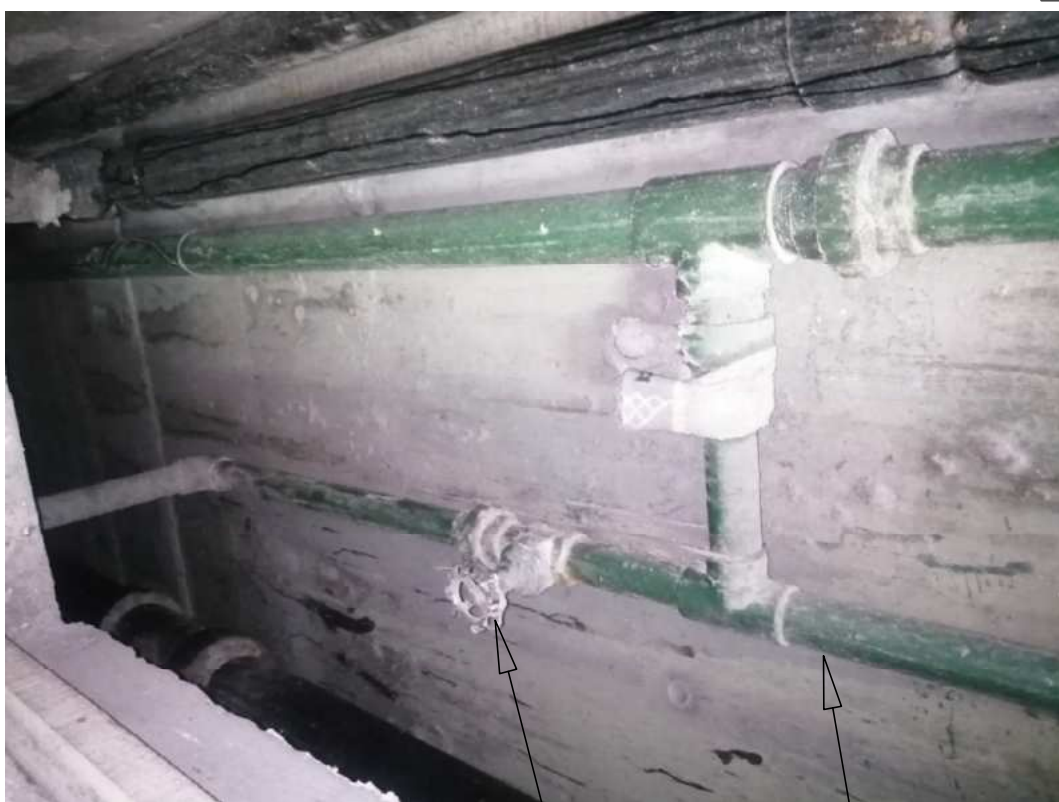
VALVULA DE CONTROL EN MAL ESTADO
