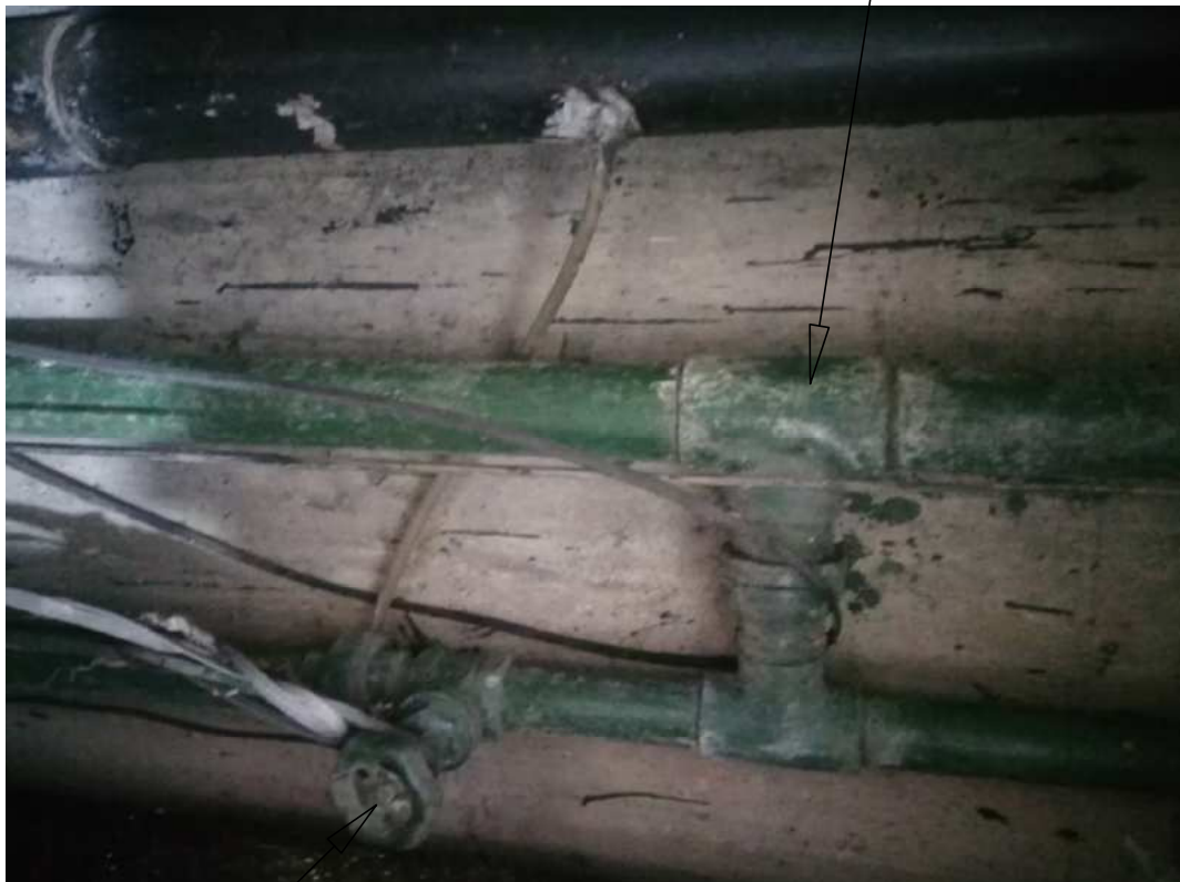
VALVULA DE CONTROL EN MAL ESTADO
