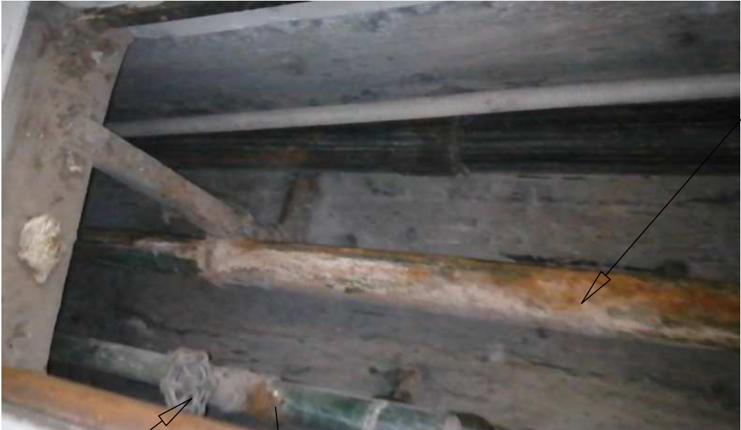
TRAMO EN FIERRO GALVANIZADO, CON PRESENCIA DE CORROSION
