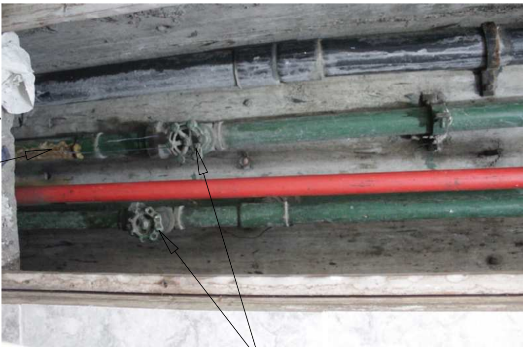
VALVULA DE CONTROL EN MAL ESTADO
