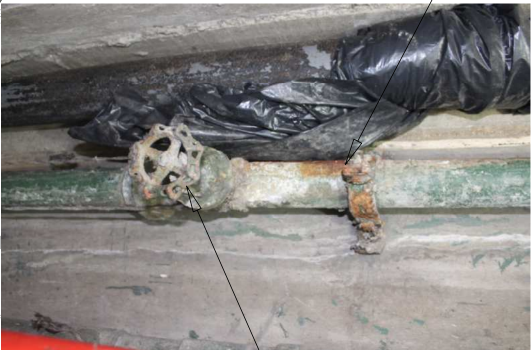
VALVULA DE CONTROL EN MAL ESTADO
