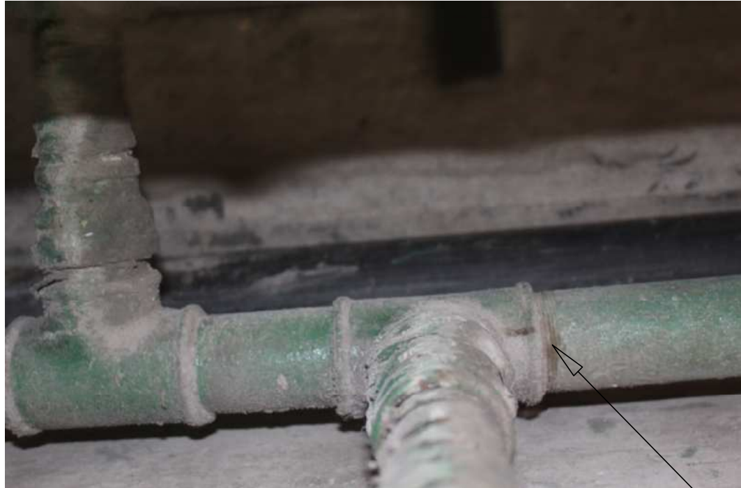
TRAMO EN FIERRO GALVANIZADO, PRESENCIA DE CORROSION
