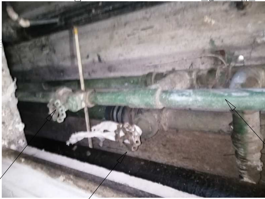
VALVULA DE CONTROL EN MAL ESTADO
