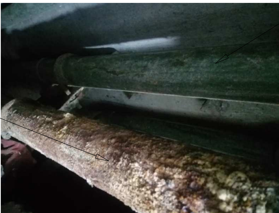
TRAMO EN FIERRO GALVANIZADO, CON PRESENCIA DE CORROSION
