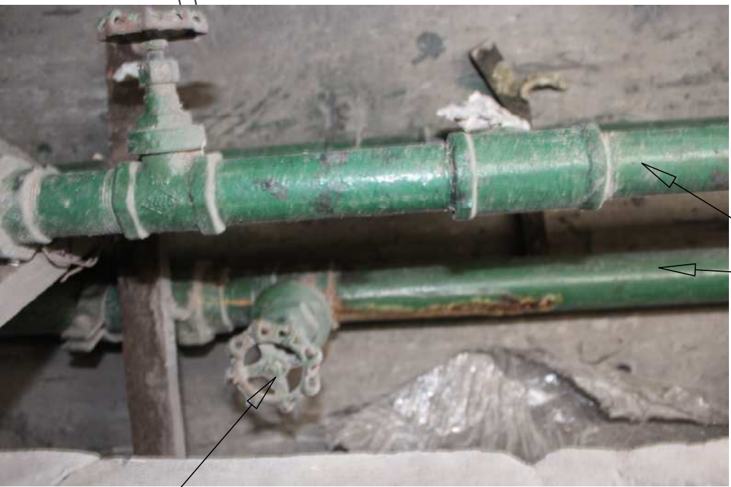
VALVULA DE CONTROL EN MAL ESTADO
