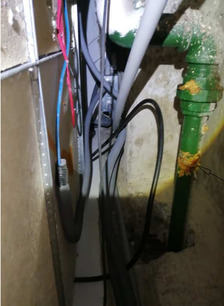
TRAMO EN FIERRO GALVANIZADO CON CORROSION
