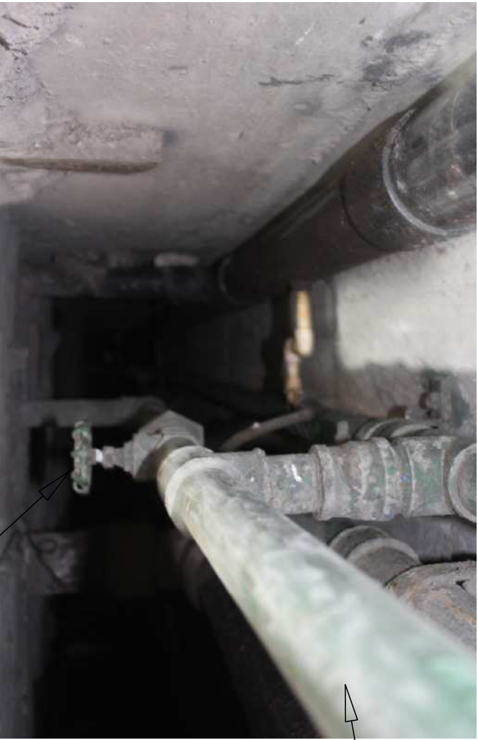
VALVULA DE CONTROL EN MAL ESTADO
