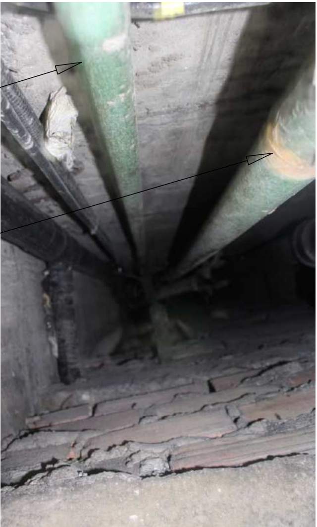
TRAMO EN FIERRO GALVANIZADO CON PRESENCIA DE CORROSION
