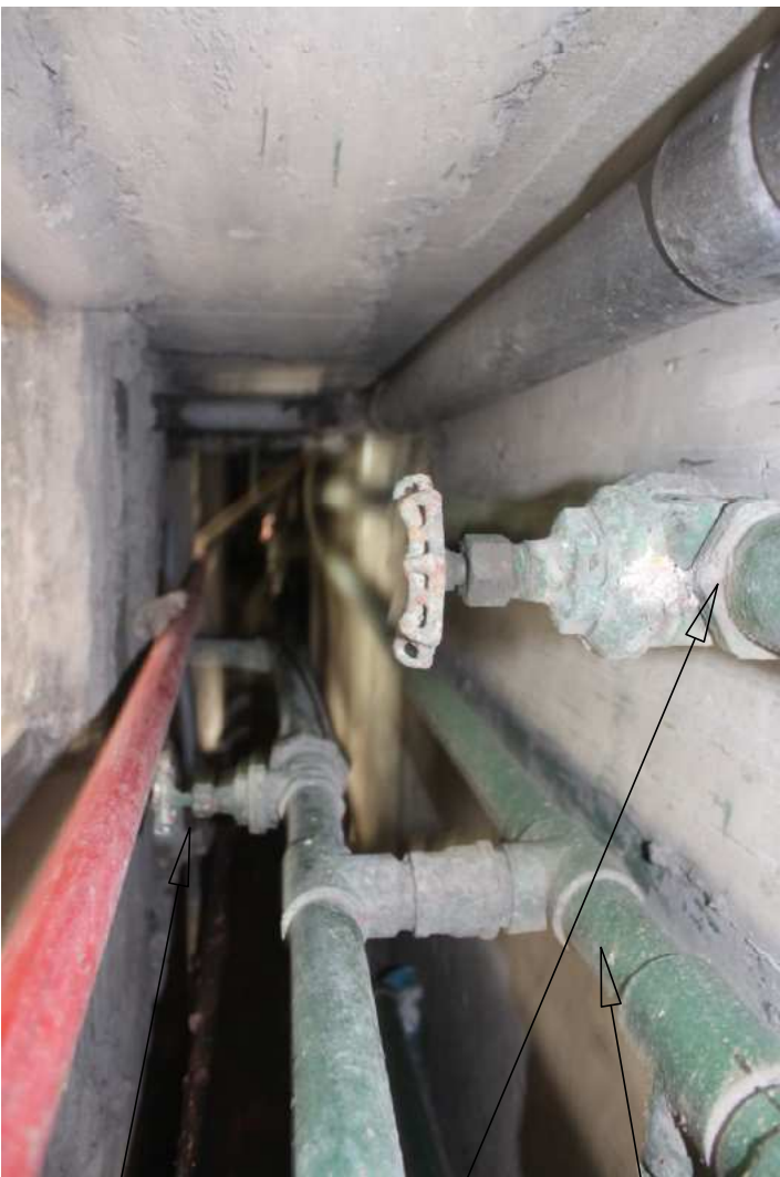
VALVULA DE CONTROL EN MAL ESTADO
