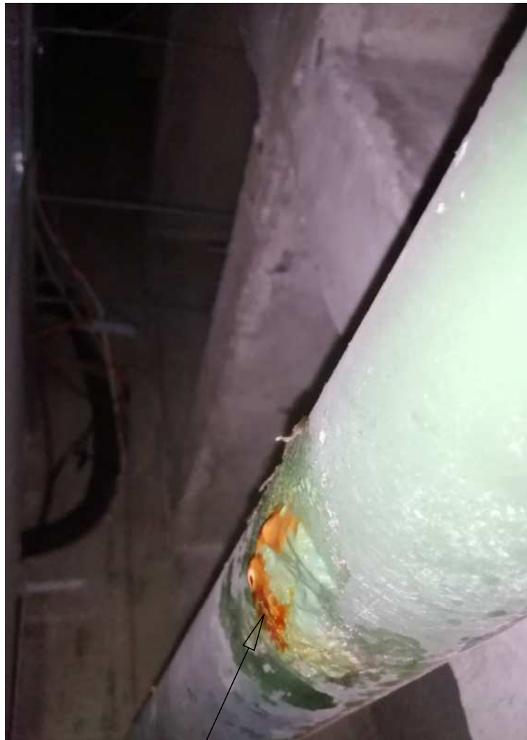
TRAMO EN FIERRO GALVANIZADO, CON PRESENCIA DE CORROSION
