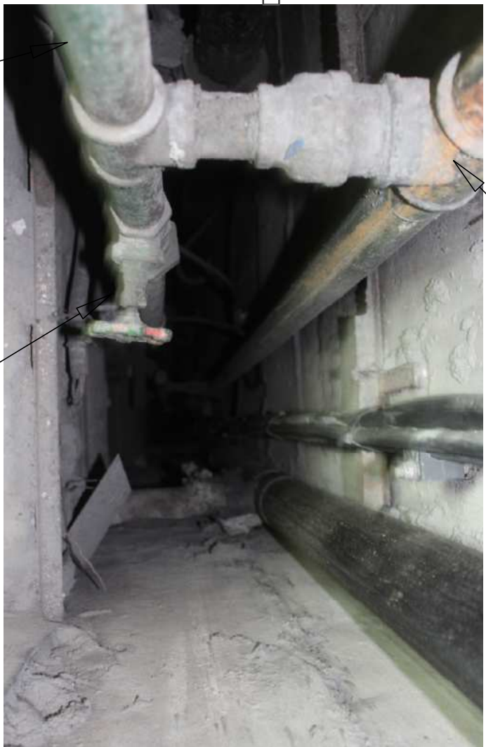
TRAMO EN FIERRO GALVANIZADO CON PRESENCIA DE CORROSION VALVULA DE CONTROL EN MAL ESTADO
