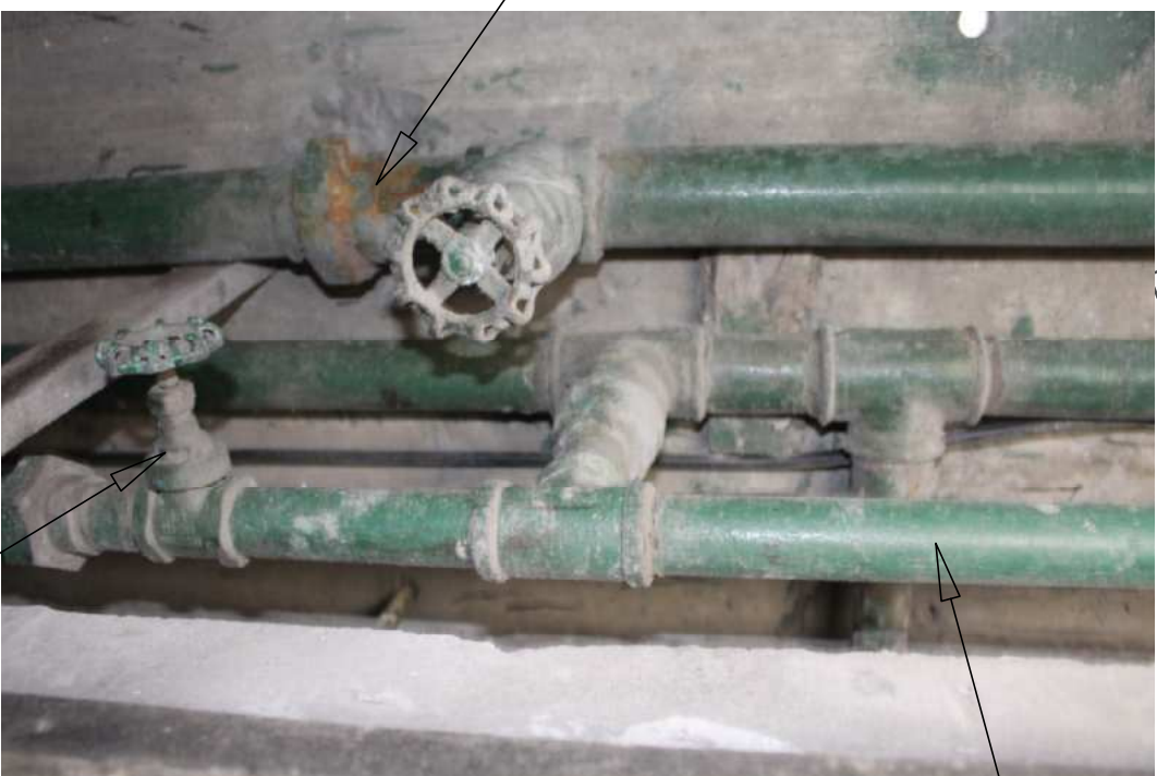
VALVULA DE CONTROL EN MAL ESTADO
