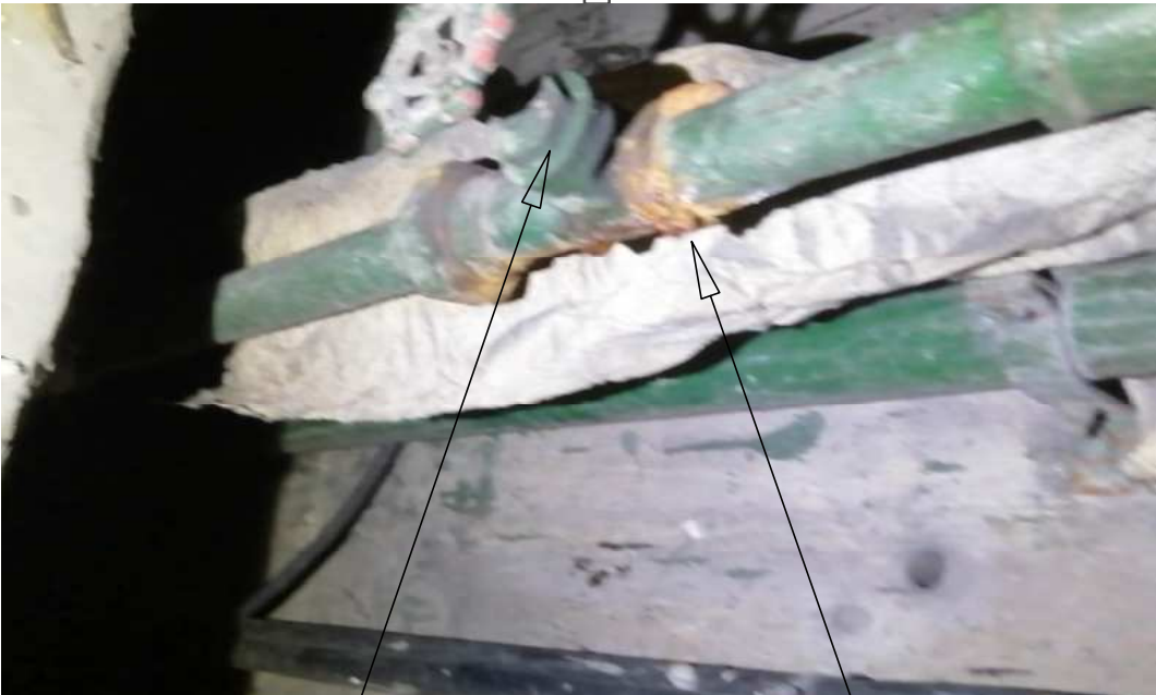
TRAMO EN FIERRO GALVANIZADO, CON PRESENCIA DE CORROSION
