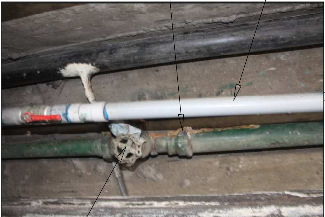
VALVULA DE CONTROL EN MAL ESTADO
