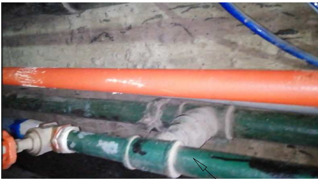
TRAMO EN FIERRO GALVANIZADO CON CORROSION
