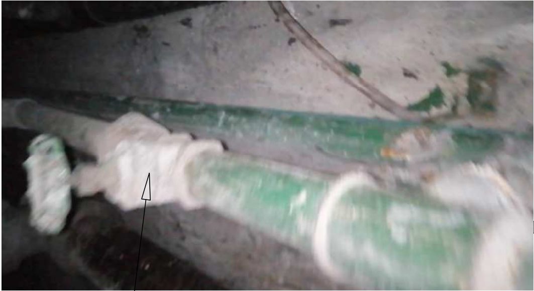
VALVULA DE CONTROL EN MAL ESTADO
