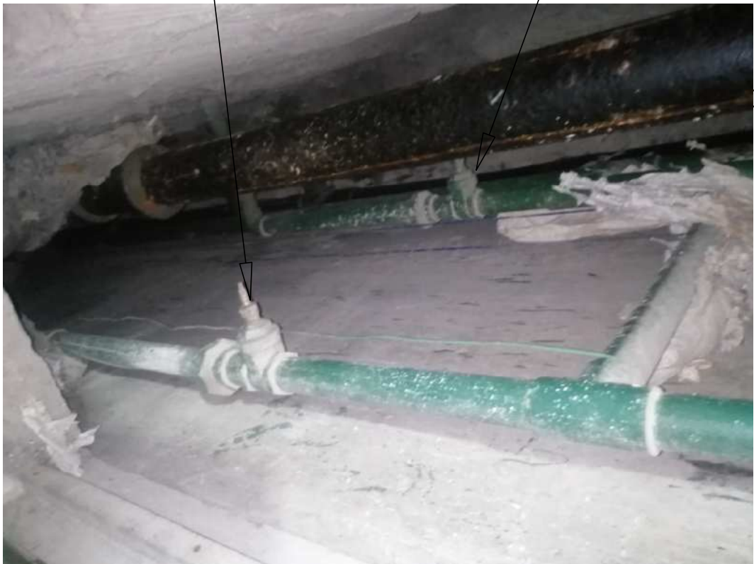
VALVULA DE CONTROL EN MAL ESTADO
