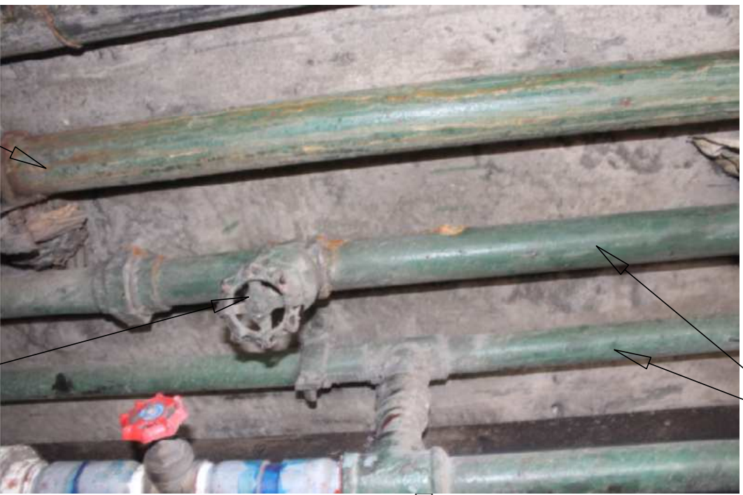
VALVULA DE CONTROL EN MAL ESTADO
