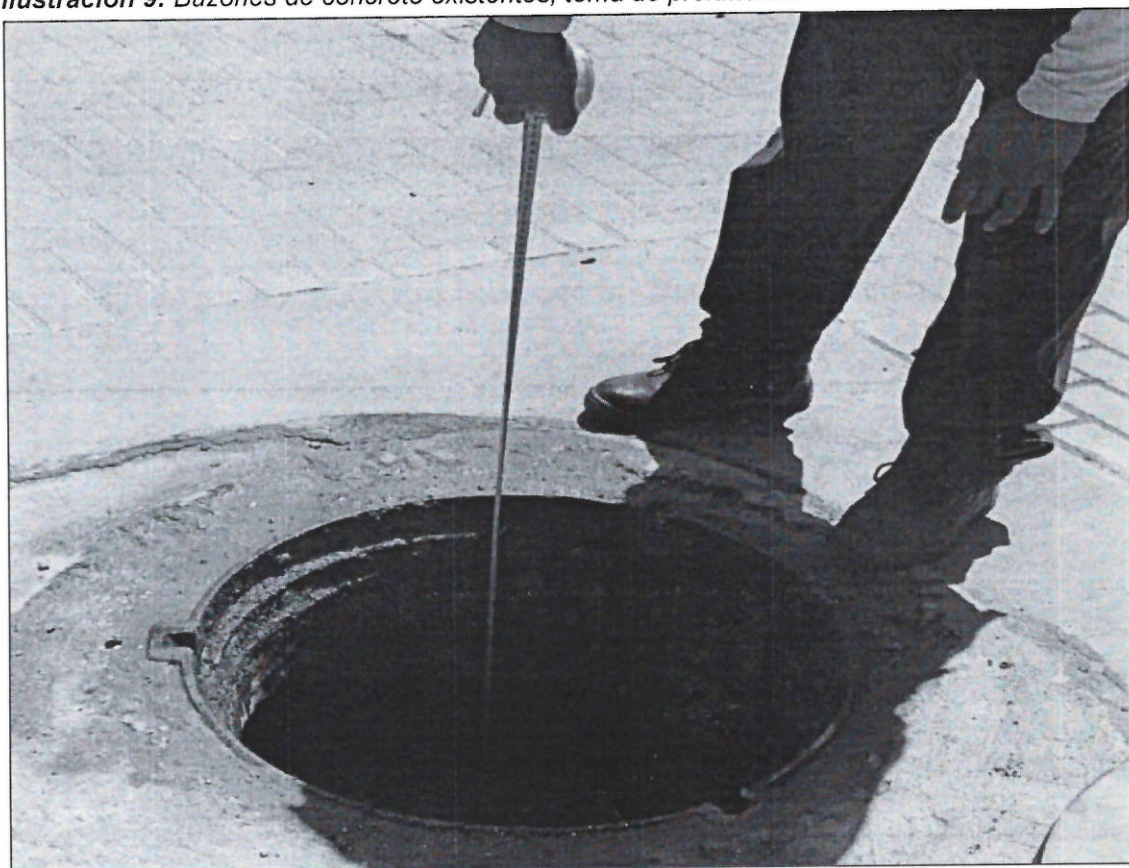
Ilustración 9: Buzones de concreto existentes, toma de profundidades.
