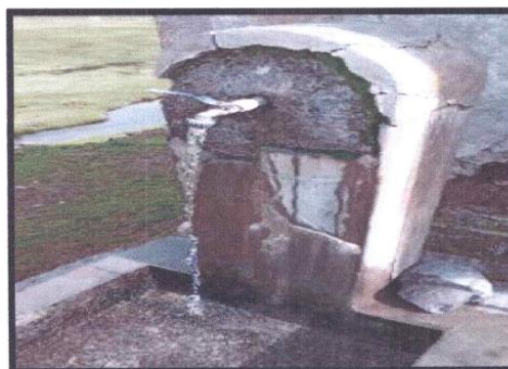
FOTOGRAFÍA N° 15 RESANE CON MORTERO EN PILETA
