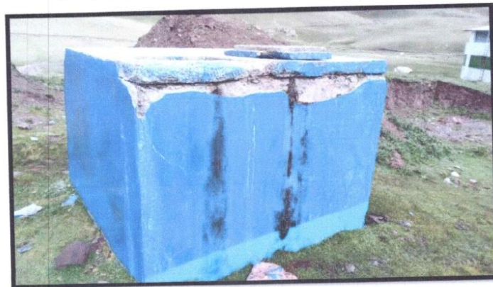
FOTOGRAFÍA N° 14 RESANE CON MORTERO EN RESERVORIO
