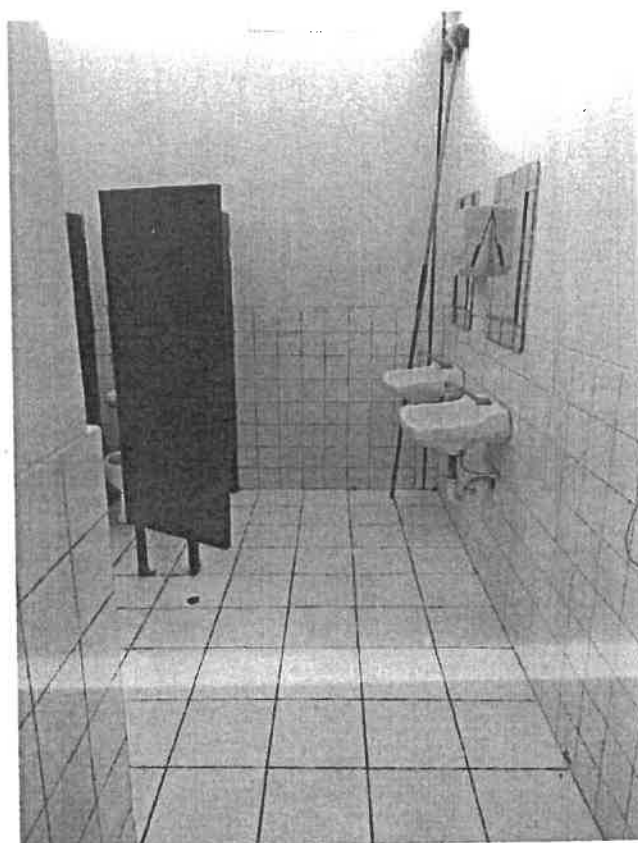
Fotografía 6. Cambio de pisos, zócalos y aparatos sanitarios en los servicios higiénicos del primer nivel del Block "D".
