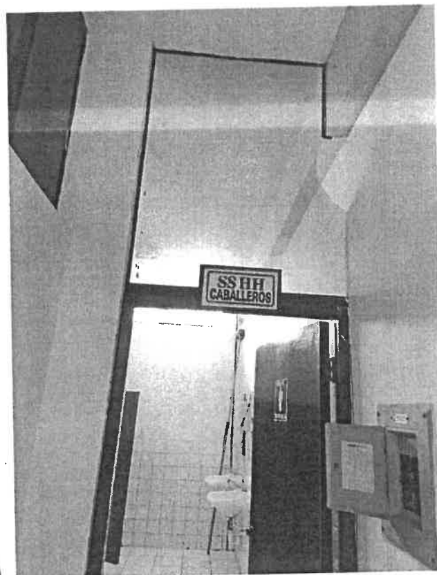
Fotografía 8. Cambio de fresquilla de vidrio por drywall y cambio de llaves termomagnéticas y tablero eléctricos por nuevos.
