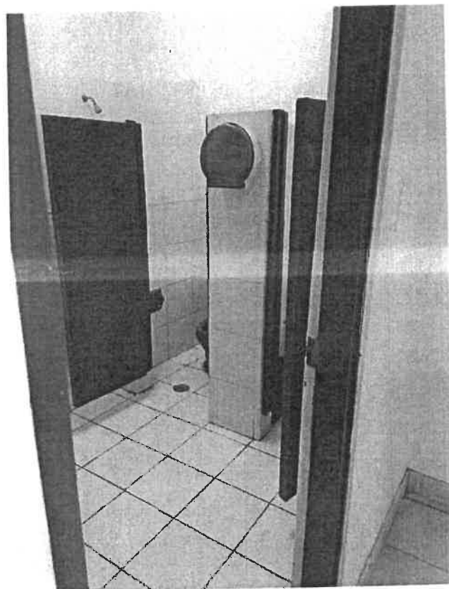
Fotografía 10. Demolición de muros divisorios de ladrillo e instalación de divisiones y puertas de melamina en los servicios higiénicos del segundo nivel del Block "D".
