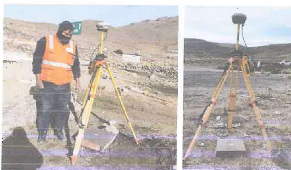
Imagen 1-12.- Monumentación de Puntos Geodésicos del proyecto
