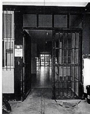
IMAGEN N° 19 Se puede apreciar que el área de residuos, en mal estado los pisos deteriorados las paredes en mas estado, no cuenta con luminarias y tomacorrientes en buen estado.
