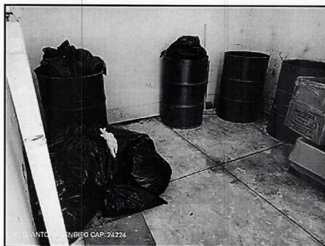
IMAGEN N° 19 Se puede apreciar que el área de residuos, en mal estado los pisos deteriorados las paredes en mas estado, no cuenta con luminarias y tomacorrientes en buen estado.
