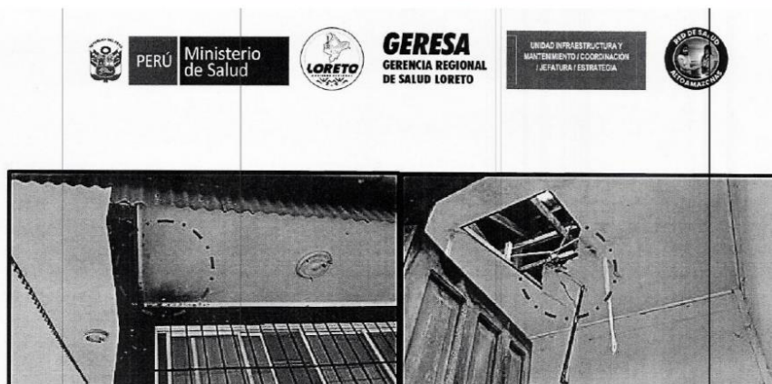
IMAGEN N°-6 Se puede apreciar uno de los ambientes del centro de salud que los cielorrasos están deteriorados, ya necesitando su cambio total.
