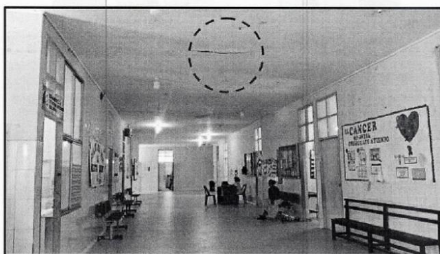
IMAGEN N°-13 Se puede apreciar los corredores del centro de salud, que en forma rápida de solucionar el cielo raso pusieron una plancha de triplay.
