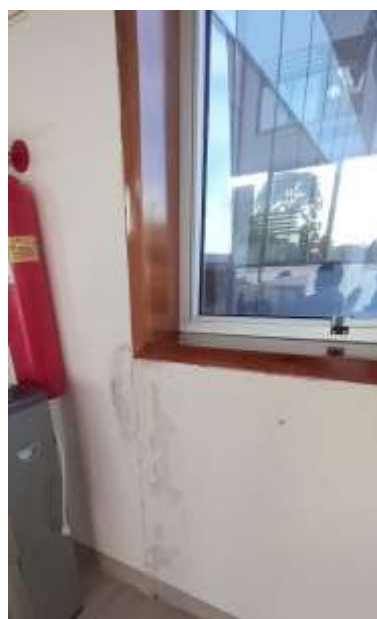
Imagen N° 27 y N° 28: Fotos de algunas superficies (planchas de drywall / fibrocemento y muros) dañadas por humedad.
