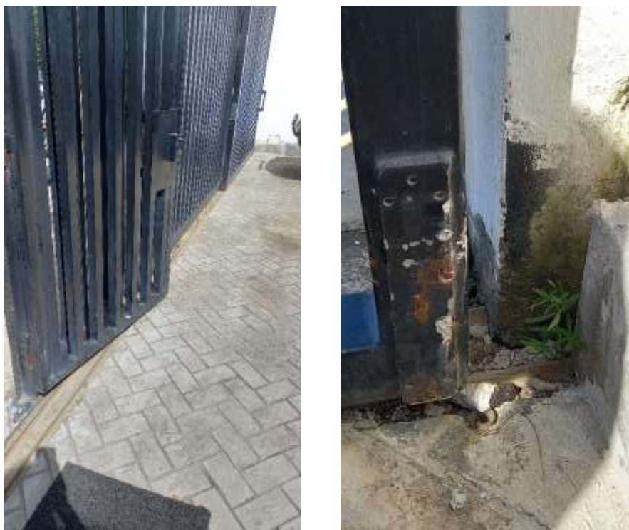
Imagen N° 01 y N° 02. Estado de la reja PR-1 existente, ubicada en el Estacionamiento
