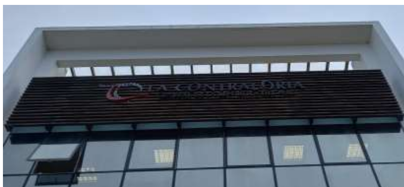
Imagen Nº 17: Foto de la celosía de madera existente.
