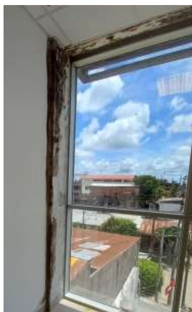
Imagen N° 27 y N° 28: Fotos de algunas superficies (planchas de drywall / fibrocemento y muros) dañadas por humedad.
