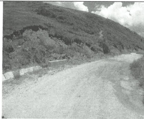
FOTO N° 03 Erosión de Material de afirmado.
