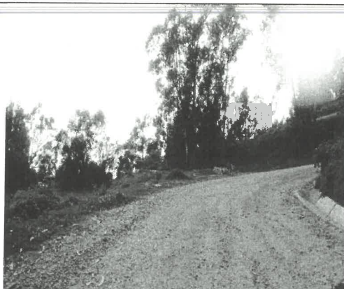
FOTO N° 05 Erosión de Material de afirmado.
