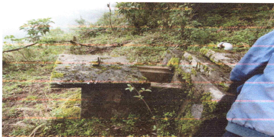
Cámara rompe presión, en malas condiciones
