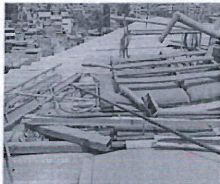
Imagen N° 01: Cobertura metálica de taller de mantenimiento y Servicios Generales sin limpieza y con puntos de filtración y sobre carga de chalarra.
