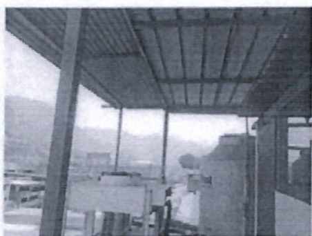
Imagen N° 03: Tramo de cobertura de fibrocemento, cobertura metálica corroída con orificios sobre las ranuras, requiere cambio de canaletas de evacuación pluvial.
