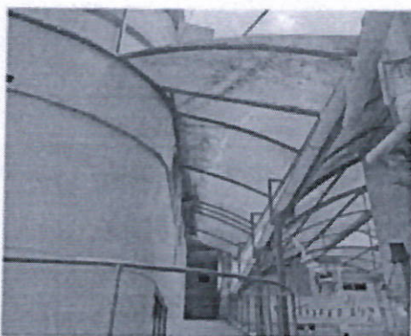
Imagen N° 07: Cobertura alveolar translucida dañado por heces de paloma, requiere limpieza y cambio de paño afectado.
