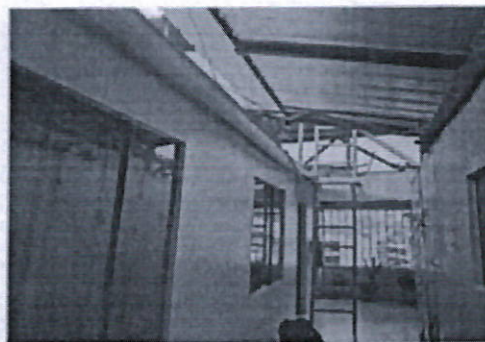
Imagen N° 04: Canaleta de PVC en pasadizo reseco, sin pendiente y sin soportes metálicos requiere cambio con nuevos soportes metálicos.
