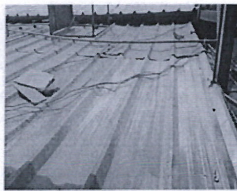
Imagen N° 02: Cobertura metálica dañada y sin pendiente, con abolladura que forma panza de agua sobre esta, acumulando el agua de lluvia.
