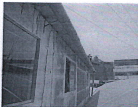
Imagen N° 05: Canaleta de PVC reseco, requiere cambiar la dirección de evacuación pluvial hacia fuera del predio del hospital.
