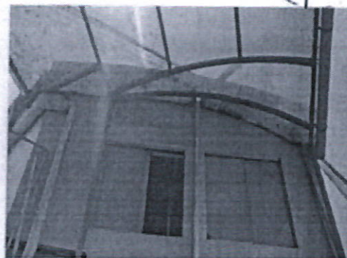
Imagen N° 06: Filtración de agua de lluvia por abertura entre cobertura y montante, paño de cobertura alveolar translucida dañado por heces de palomas, requiere cambio.
