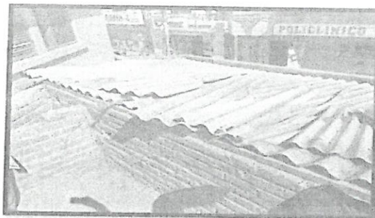
Superficie de techo con moho.
