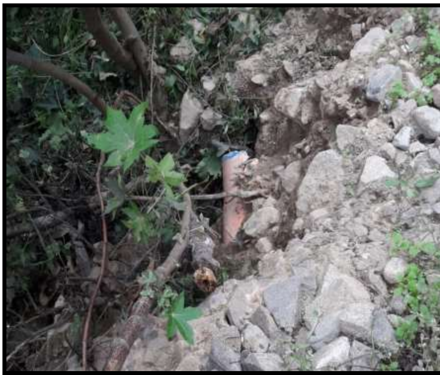
Imagen N° 04: Punto de tubería rota que fue afectado por los huayco.
