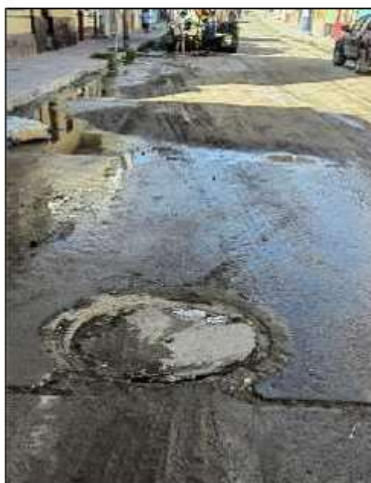
Ilustración 6: Buzón en mal estado con afloramiento de aguas
