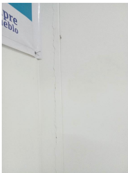
Foto 12: Fisuras en columna de auditorio.
