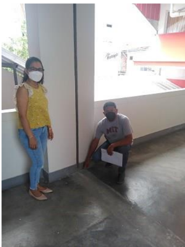
Foto 9: En pasadizo de 2do piso, se visualiza han sellado la junta de dilatación en piso con mortero, la cual requiere ser rellenada con plancha de Tecnopor de 6" y sellado con elastomérico flexible y tapa junta metálico.
