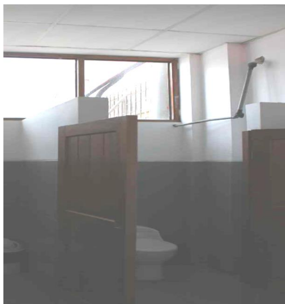
Foto 22: Tubería de agua que se encuentra expuesta en baño de varones de 2do piso.
