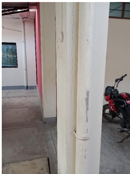
Foto 15: Fisuras en columna de pasadizo de 1er piso frente a estacionamiento.
