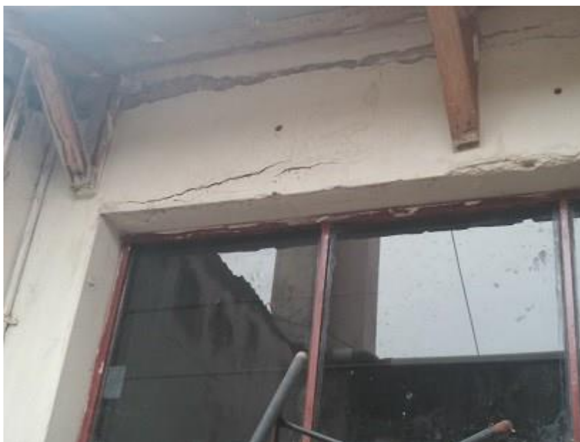
Foto 11: Fisuras en viga peraltada de taller de albañilería.
