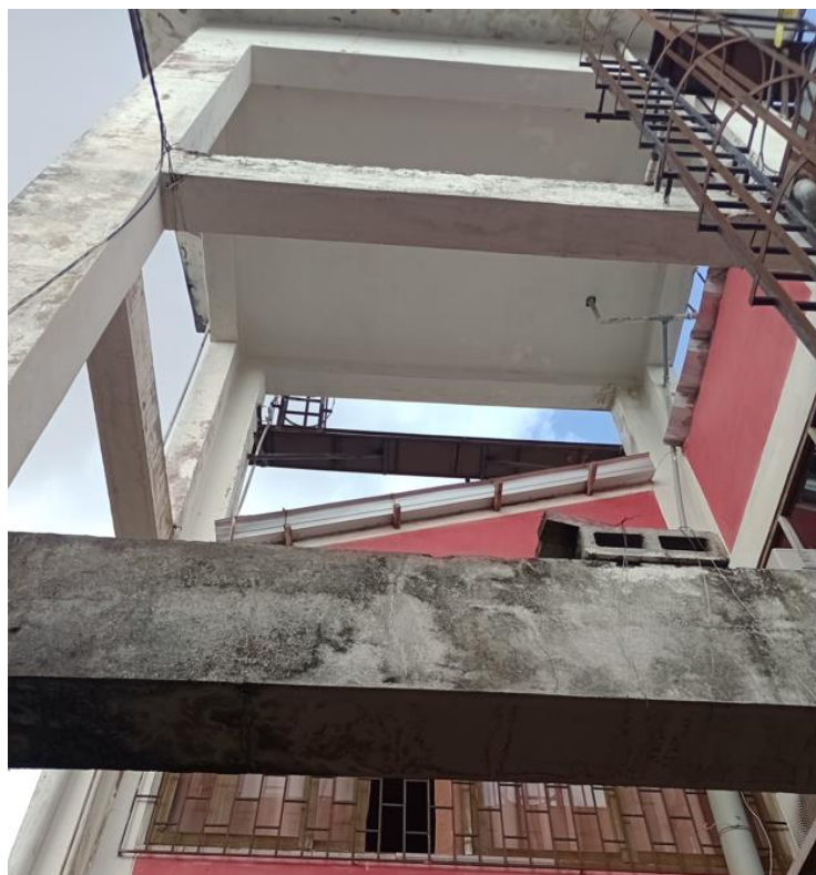
Foto 18: Fisuras en viga de tanque elevado.
