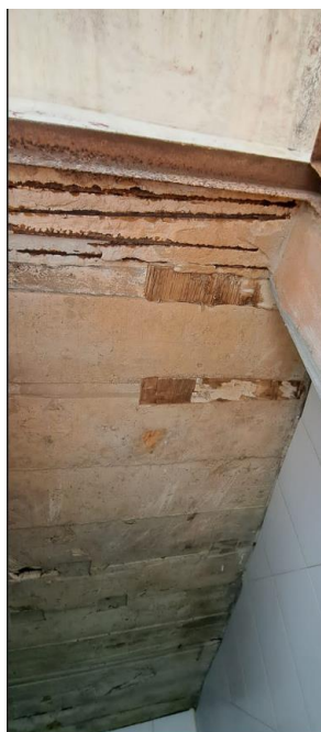
Foto 6: Presencia de corrosión en acero de refuerzo inferior de techo de tanque elevado.
