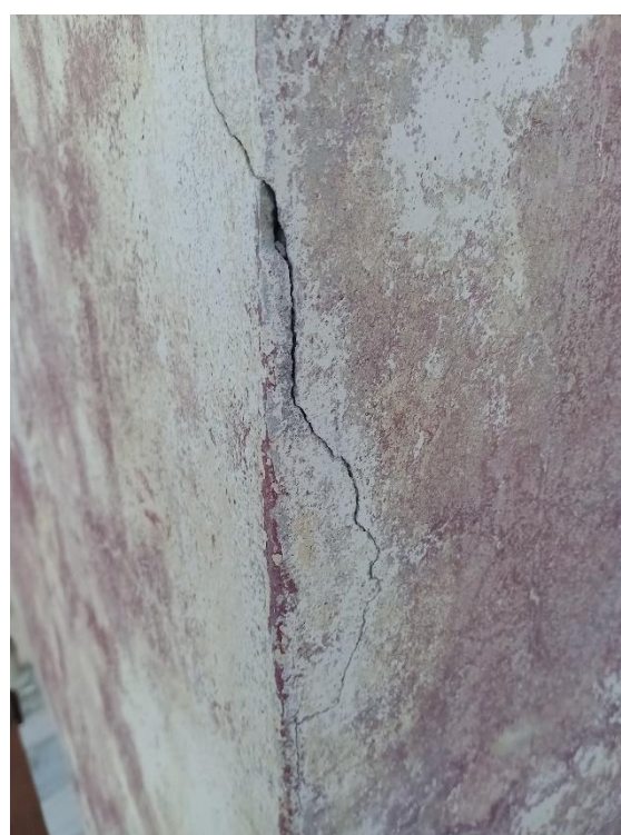
Foto 2: Desprendimiento del concreto en vigas de patio a lado de cisterna.
