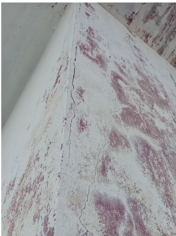
Foto 2: Desprendimiento del concreto en vigas de patio a lado de cisterna.
