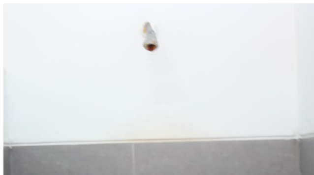
Foto 21: Presencia de óxido en ducha de baño de varones 1er piso.
