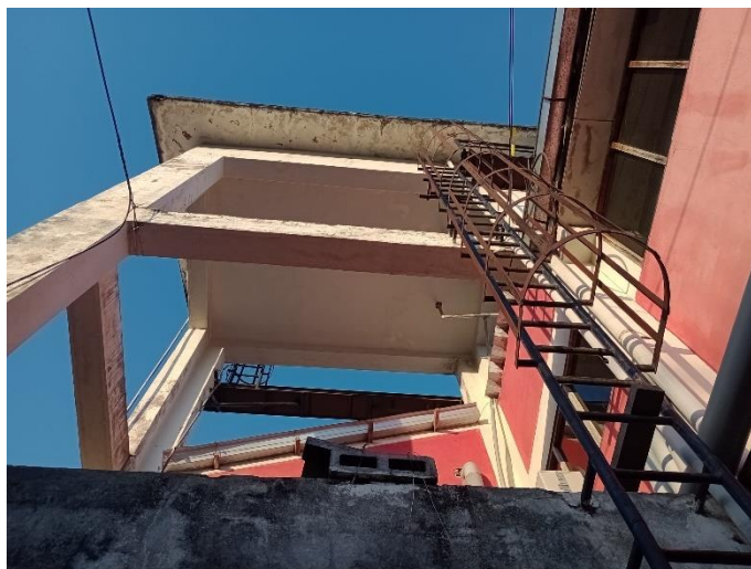
Foto 19: Fisuras en viga de tanque elevado.
