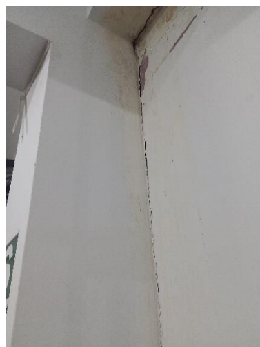
Foto 13: Fisuras en vigas y columna en almacén.
