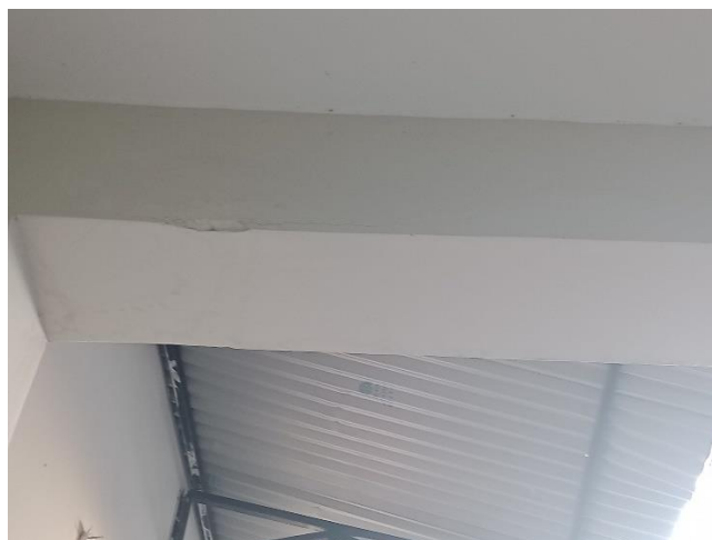
Foto 16: Fisuras en viga de pasadizo de 1er piso frente a escalera.
