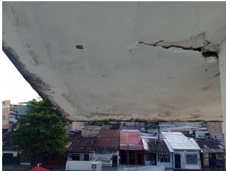
Foto 5: Desprendimiento del concreto en alero de techo de tanque cisterna (frente a calle pablo rossell).
