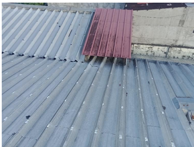
Foto 25: Cobertura existente en pasadizo y aula 2, el cual tiene problemas de filtraciones.
