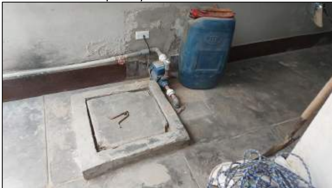
Figura N° 42: Tapa de ingreso a la cisterna, la bomba y tuberías se encuentran expuestas y en malas condiciones.
