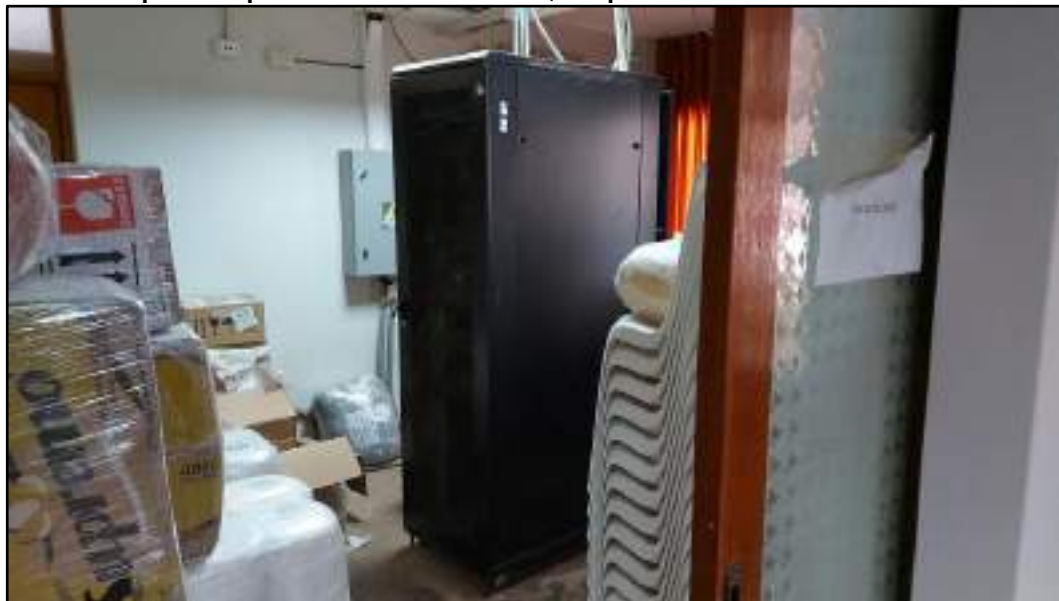
Figura N° 50: Data center, área 17.80 m2, el área es usada también con almacén debido al poco espacio en los ambientes, los pisos se encuentran en mal estado
