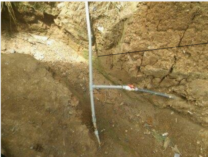
Imagen N°7. Tubería de la red de distribución expuesta
