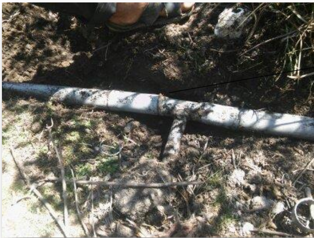
Imagen N°4 Tubería en mal estado y expuesta
