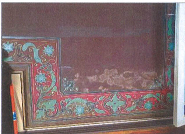
Figura 24 Vista general del deterioro por humedades en muro del segundo nivel. También evidencia una reintegración cromática "imitativa" que difiere en tonalidad y brillo respecto a la pintura original.
