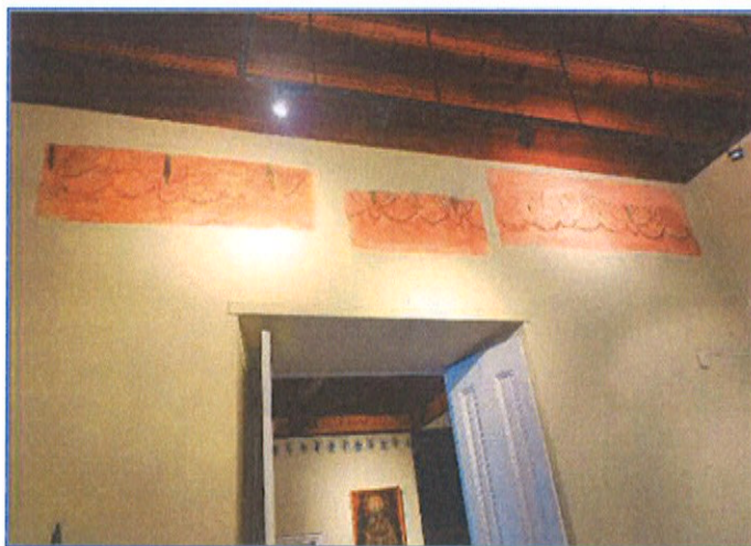
Figura 16 (derecha) Pintura mural en sala de exposición. Evidencia intervenciones anteriores de reintegración cromática y aplicación de enlucidos finos
