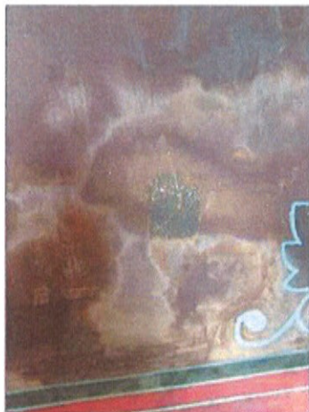
21 Figura 223 Detalle del deterioro por humedad en muro del segundo nivel (Tribunal Mayor de Cuentas).
