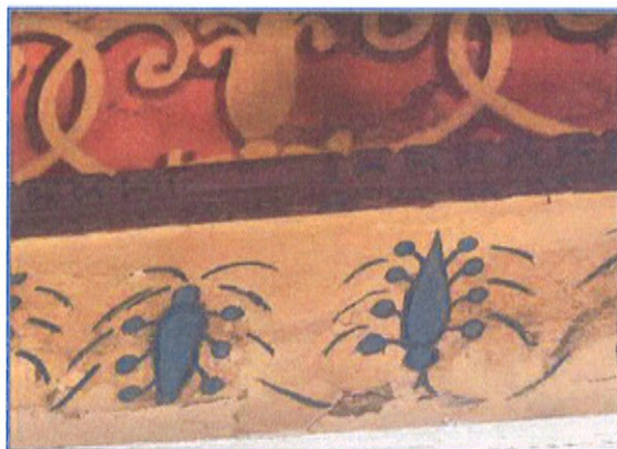
Figura 13 (arriba) Friso superior con desprendimiento de enlucido fino y capa pictórica. Se observa repintes con látex.
