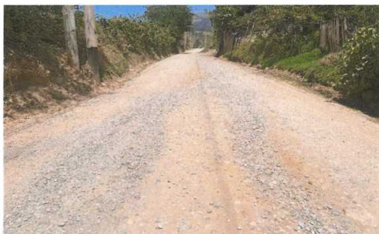
Fotografía N° 2: Ahuellamiento y erosión, progresiva KM 00+500
