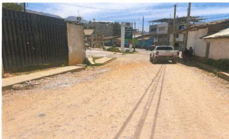
Fotografía N° 1: Ahuellamiento, progresiva KM 00+000-00+250
