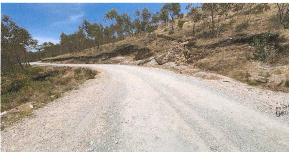
Fotografía N° 27: Presencia de Ahuellamiento en el Km 14+000
