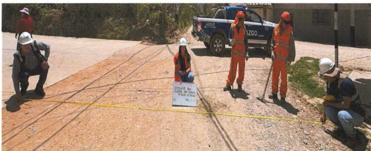
Fotografía N° 03 – Km. 00+500 ancho de la calzada
