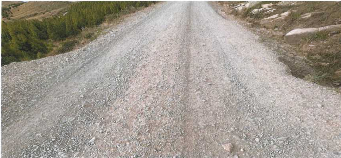
Fotografía N° 31: Presencia de Ahuellamiento en el Km 17+750
