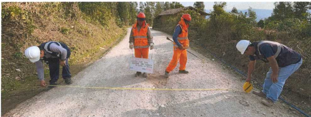
Fotografía N° 19- Km. 04+500 ancho de la calzada
