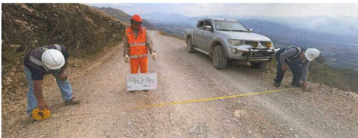
Fotografía N° 63– Km. 15+500 ancho de la calzada
