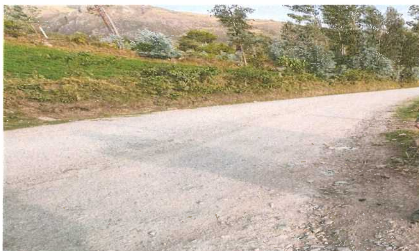
Fotografía N° 14: Presencia de Ahuellamiento en el Km 05+000
