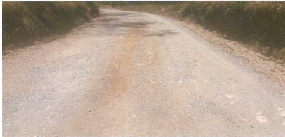
Fotografía N° 23: Presencia de Ahuellamiento y Erosión en el Km 11+750
