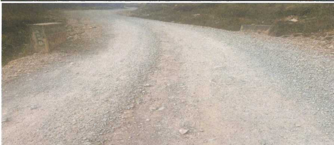
Fotografía N° 28: Presencia de Erosión en el Km 14+750
