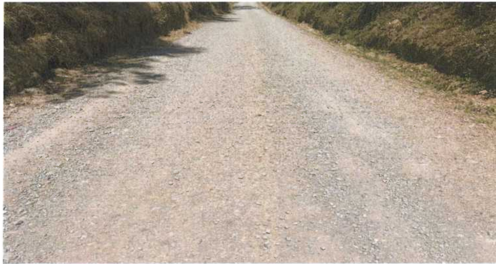
Fotografía N° 22: Presencia de Erosión y Ahuellamiento en el Km 10+250
