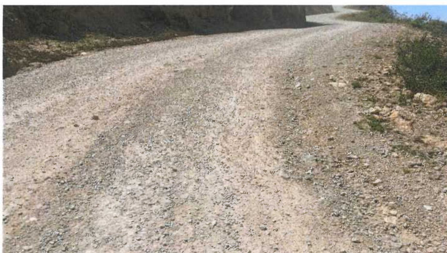
Fotografía N° 21: Presencia de Erosión y ahuellamiento en el Km 09+250
