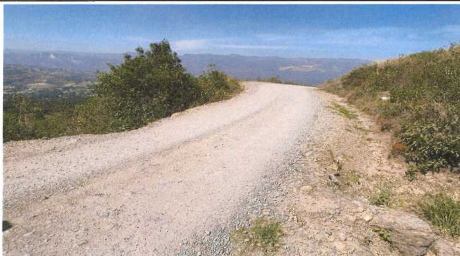
Fotografía N° 19: Presencia de ahuellamiento y Erosión en el Km 07+750
