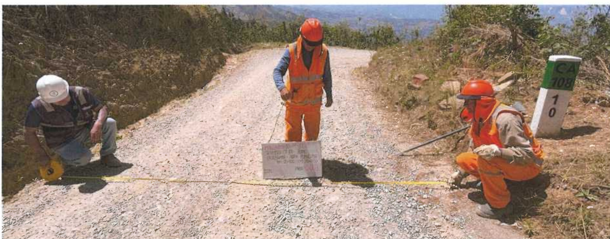
Fotografia N° 41– Km. 10+000 ancho de la calzada
