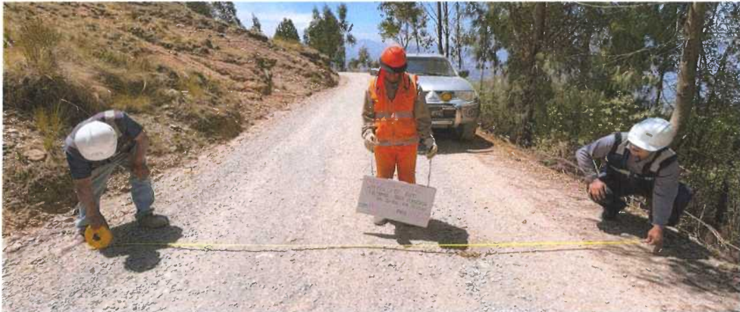
Fotografía N° 46– Km. 11+250 ancho de la calzada
