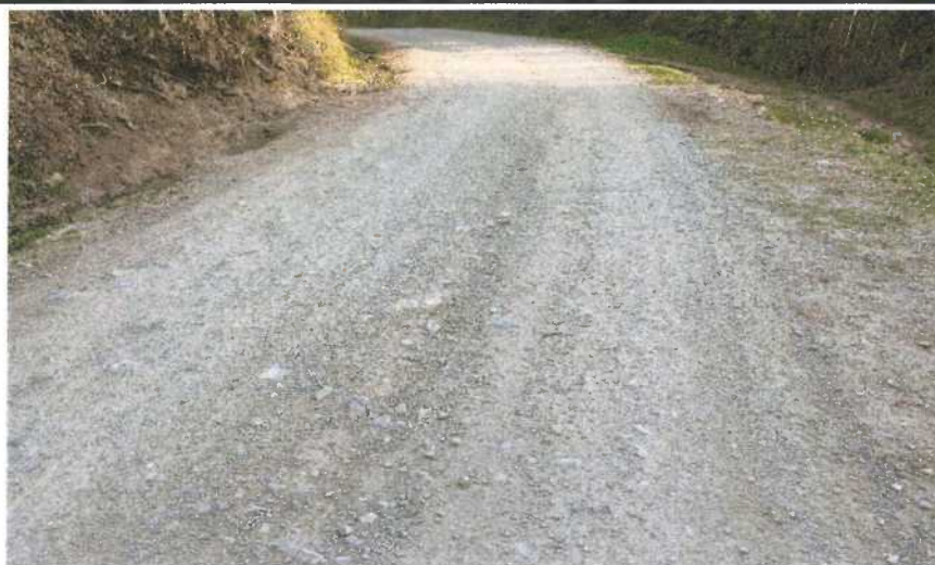
Fotografía N° 13: Presencia de Erosión en el Km 04+750
