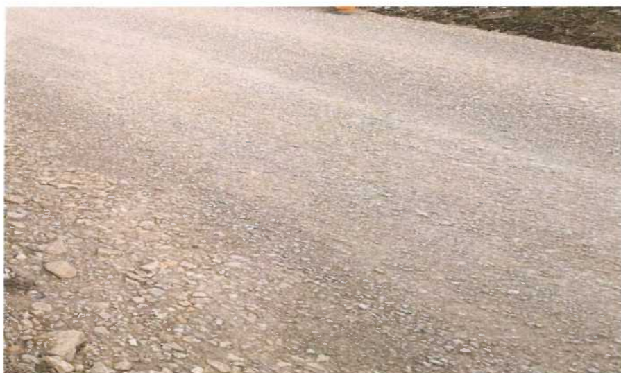
Fotografía N° 35: Presencia de Ahuellamiento en el KM 20+000
