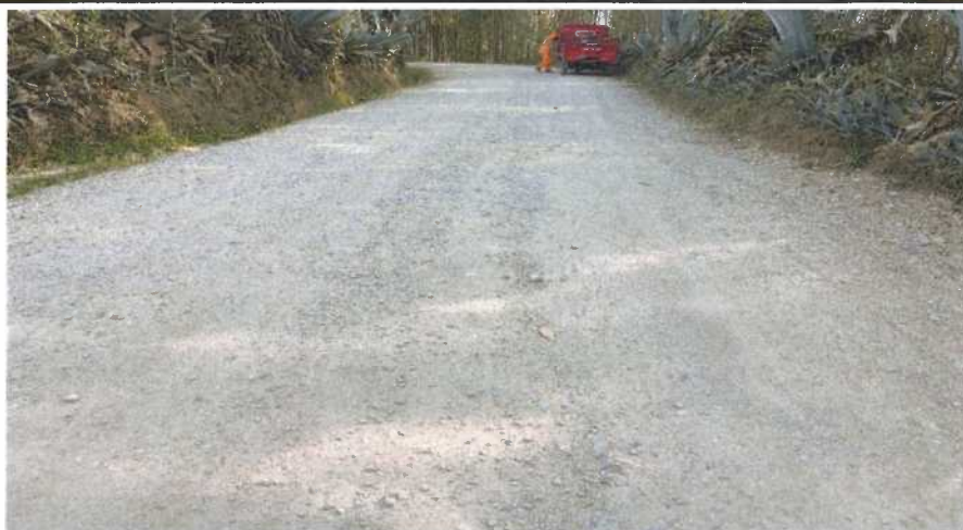
Fotografía N° 10: Presencia de Erosión progresiva Km 03+750
