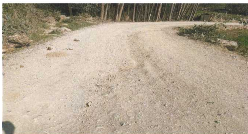
Fotografía N° 6: Erosión progresiva KM 02+500
