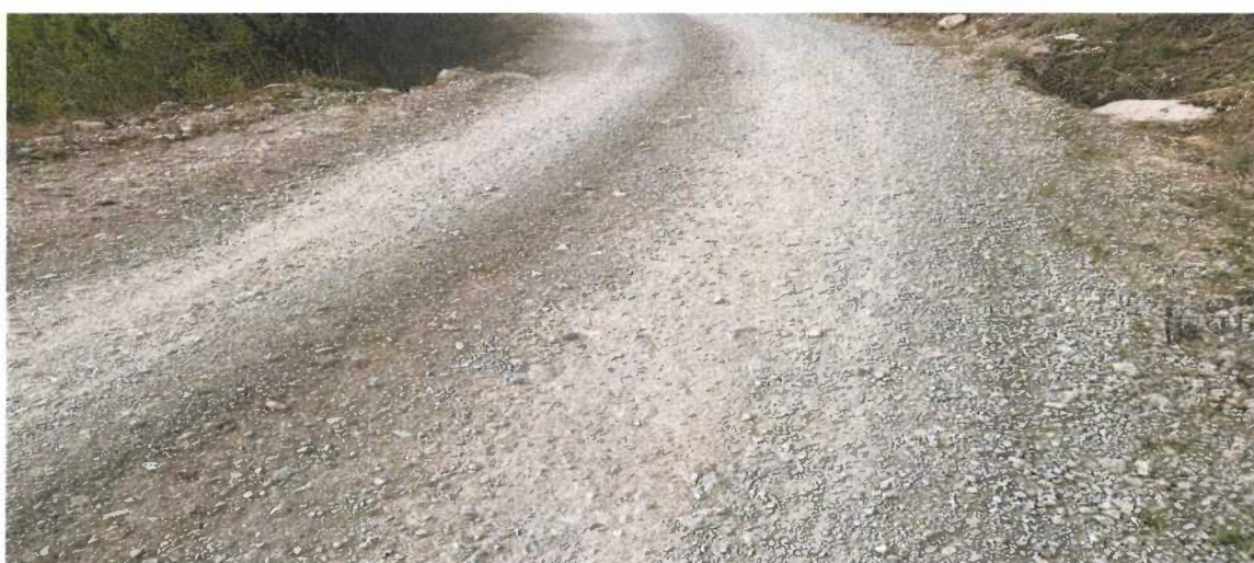
Fotografía N° 30: Presencia de Ahuellamiento y Erosión en el Km 17+250
