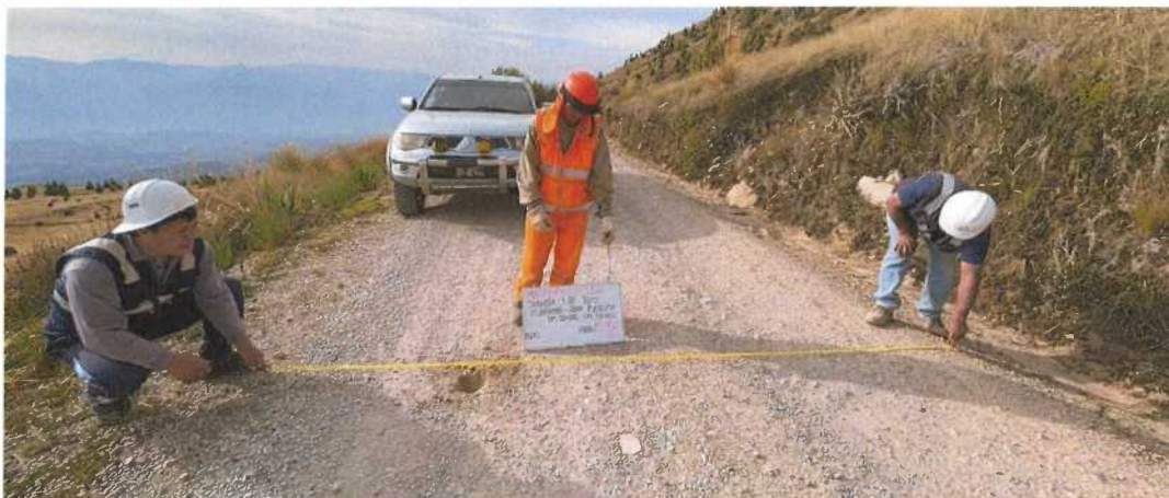
Fotografia N° 76– Km. 18+750 ancho de la calzada
