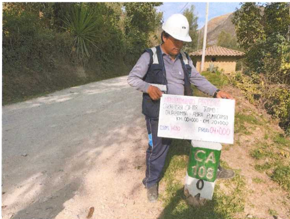
Fotografía N° 07– KM 04+000 Poste KM, en mal estado
