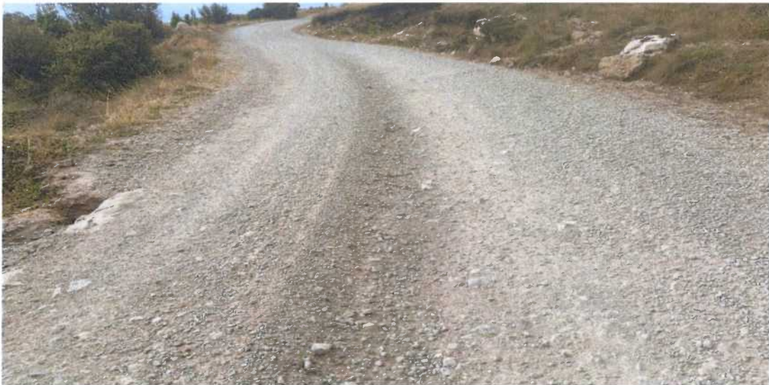
Fotografía N° 32: Presencia de Erosión en el Km 18+000
