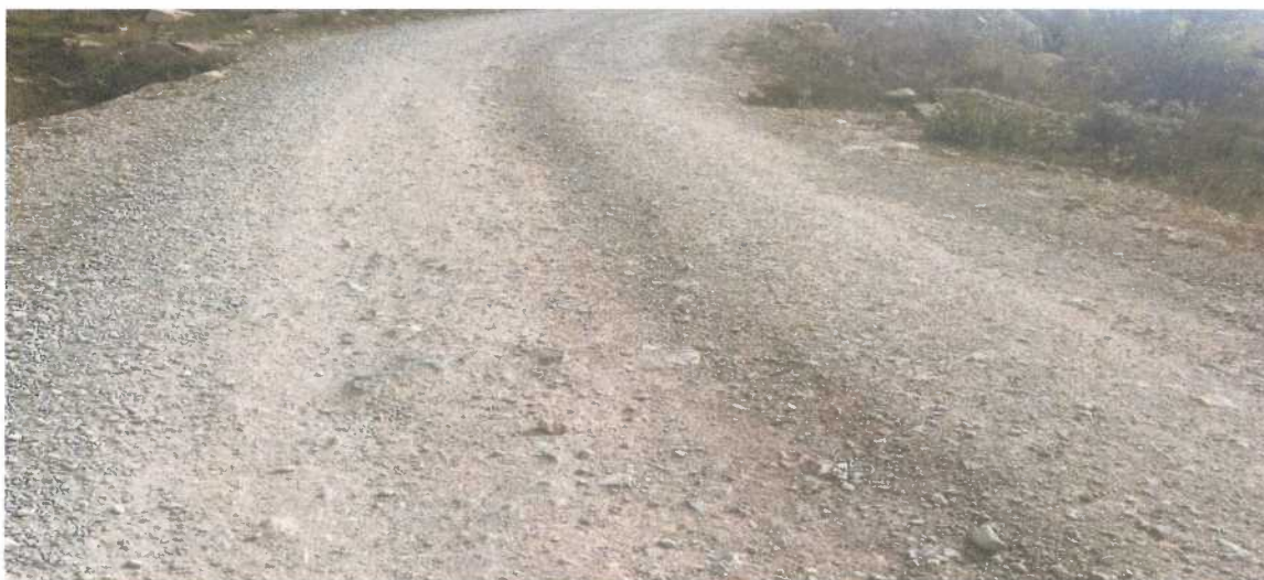
Fotografía N° 29: Presencia de Ahuellamiento y Erosión en el Km 16+000
