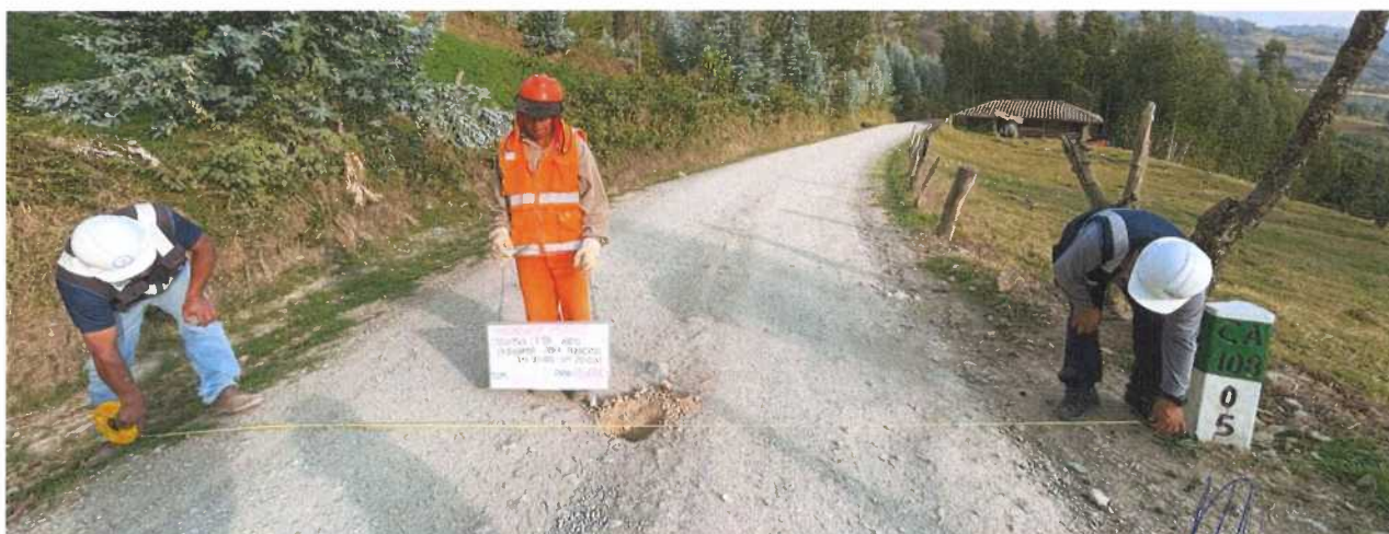
Fotografía N° 21- Km. 05+000 ancho de la calzada
