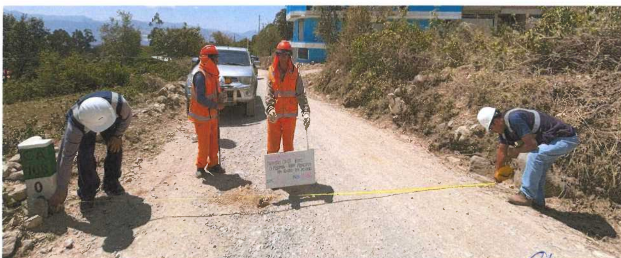
Fotografía N° 09 – Km. 02+000 ancho de la calzada
