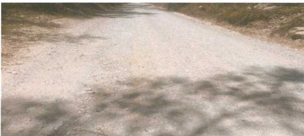
Fotografía N° 26: Presencia de Erosión en el Km 12+500
