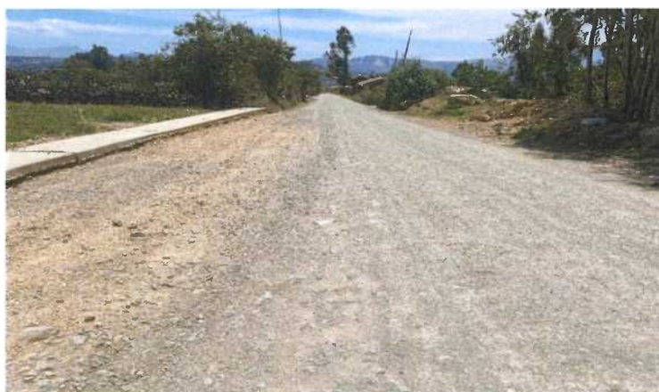
Fotografía N° 3: Ahuellamiento y erosión, progresiva KM 00+750
