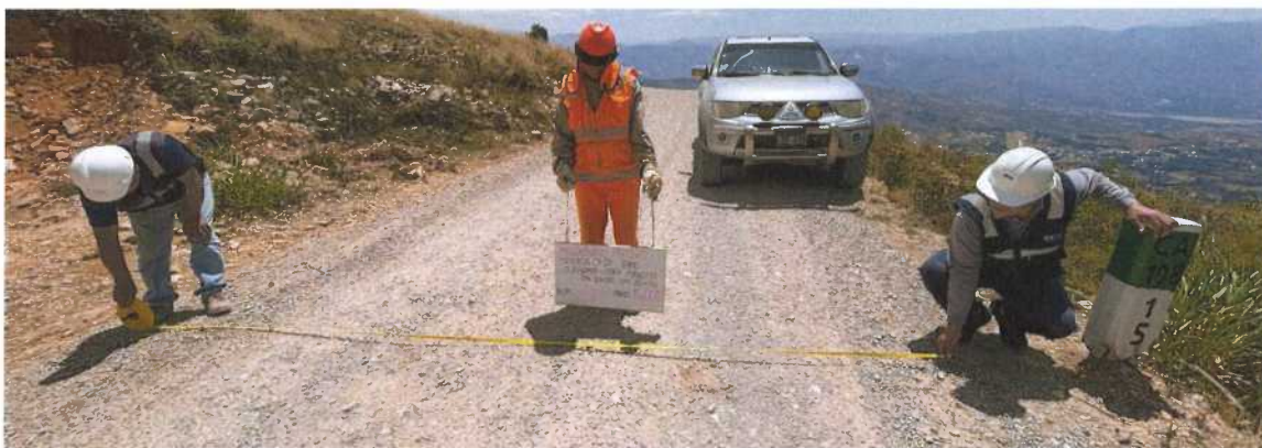
Fotografía N° 61– Km. 15+000 ancho de la calzada
