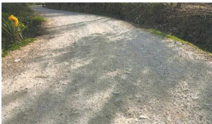
Fotografía N° 12: Presencia de Erosión progresiva Km 04+250
