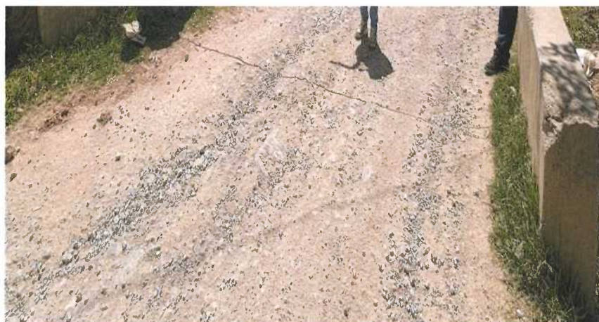
Fotografía N° 5: Erosión progresiva KM 01+250
