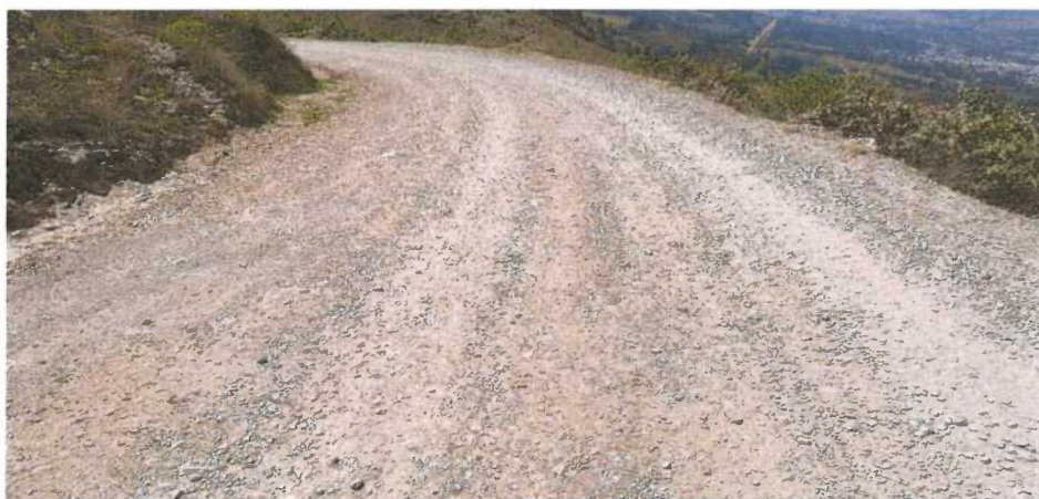
Fotografía N° 20: Presencia de ahuellamiento y Erosión en el Km 08+250
