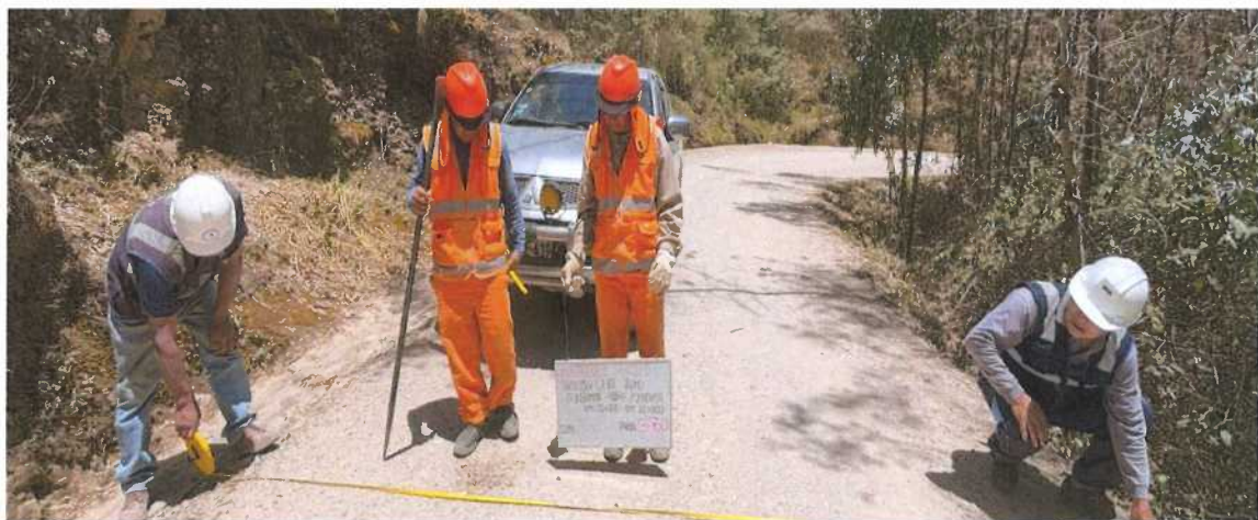
Fotografía N° 56– Km. 13+750 ancho de la calzada
