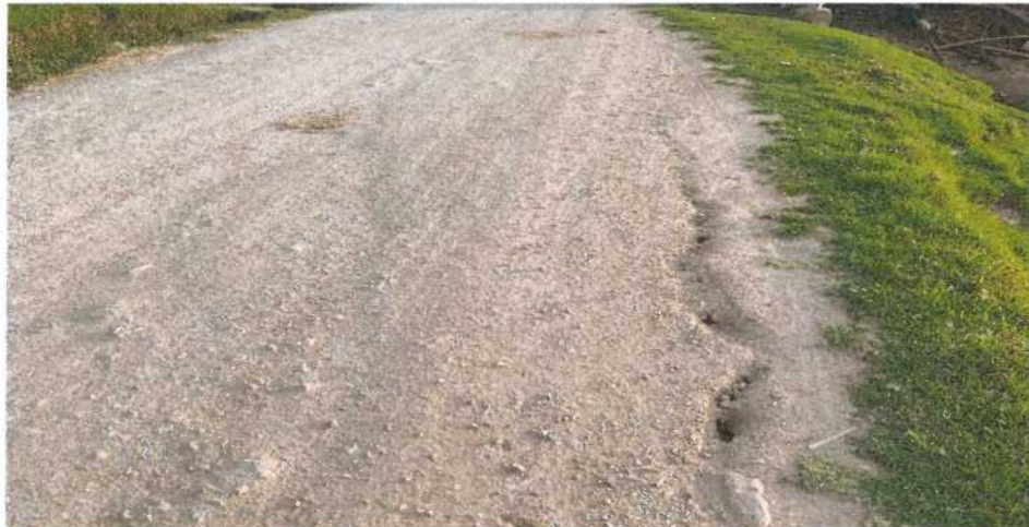
Fotografía N° 17: Presencia de Erosión y ahuellamiento en el Km 6+250
