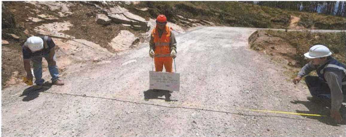
Fotografía N° 55– Km. 13+500 ancho de la calzada
