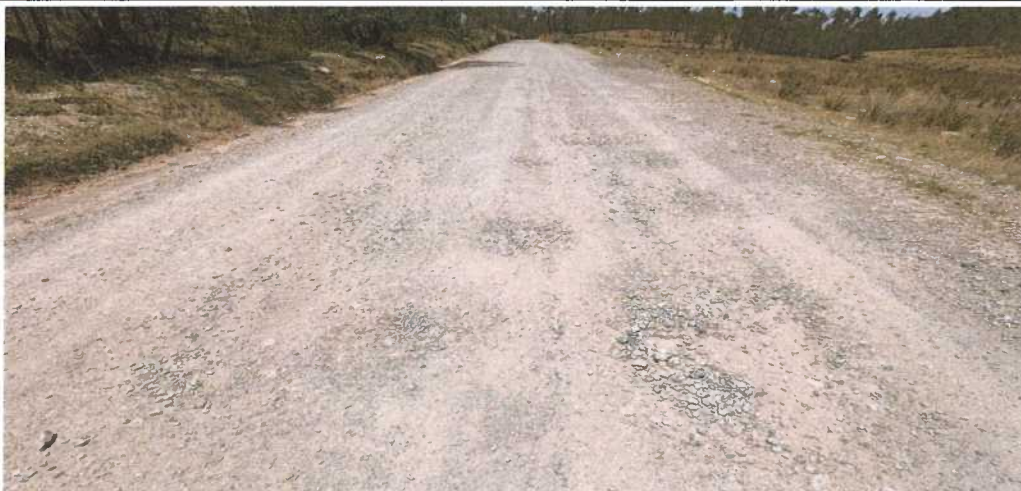
Fotografía N° 25: Presencia de Erosión en el Km 12+250
