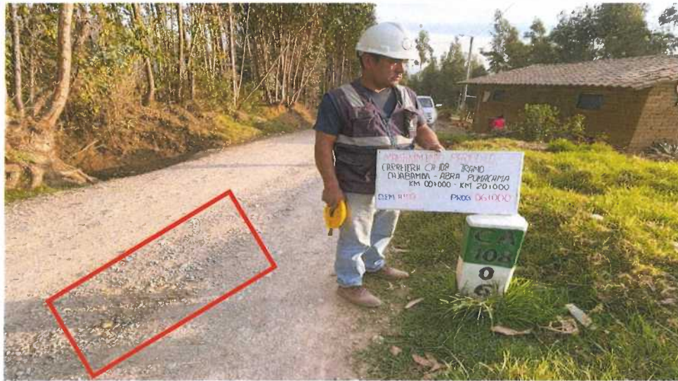
Fotografía N° 16: Presencia de Erosión en el Km 06+000
