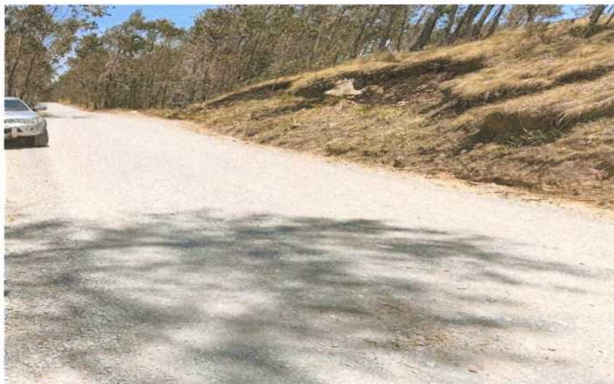
Fotografía N° 24: Presencia de Erosión en el Km 12+000
