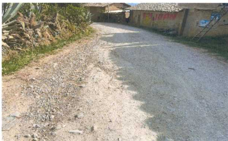
Fotografía N° 09: Erosión progresiva KM 03+250
