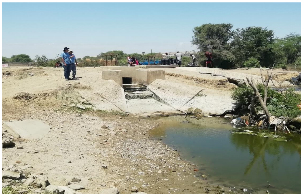
Foto N° 04. Vista de la estructura de mampostería de piedra, al inicio del canal en tierra.
