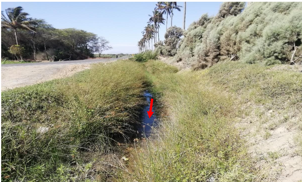
Foto N° 08. Vista del canal Guayaquil en la progresiva km 1+300, se puede apreciar vegetación en los taludes.
