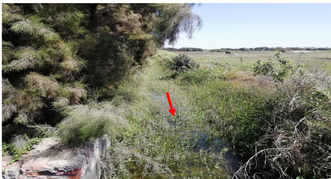
Foto N° 11. Vista del canal Guayaquil en la progresiva km 6+000, se puede apreciar vegetación en el fondo y en los taludes.
