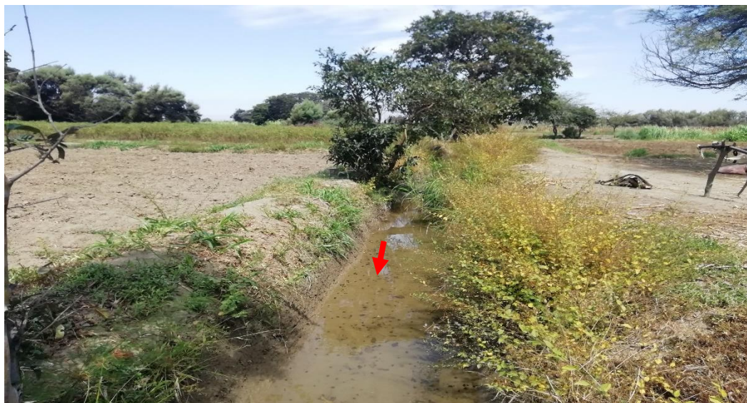
Foto N° 13. Vista del canal Alan García en la progresiva km 0+120, se puede apreciar gran cantidad de vegetación en los taludes.
