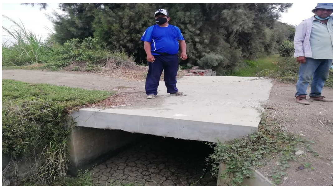
Foto N° 30. Vista del Puente vehicular de concreto, en la progresiva km 6+015 del canal Guayaquil, se encuentra en regular estado de conservación.
