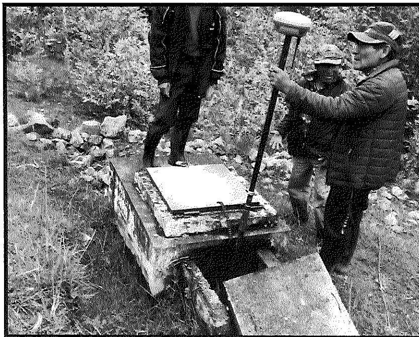
FOTOGRAFIA N° 12. CAMARA ROMPE PRESION DETERIORADA Y CON TAPAS OXIDADAS.
