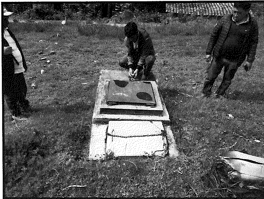
FOTOGRAFIA N° 13. CAMARA ROMPE PRESION SIN FUNCIONAMIENTO.
