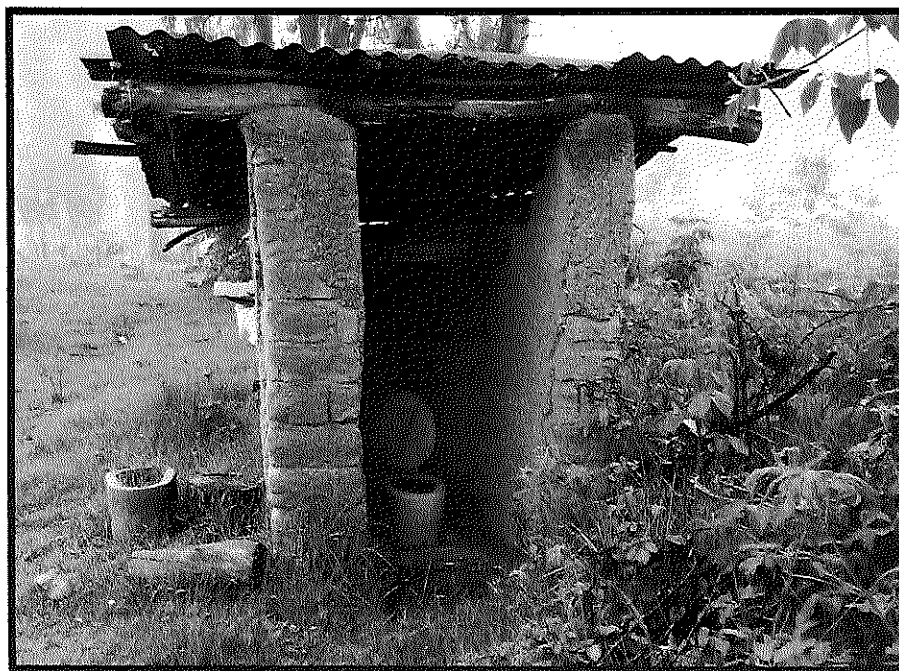
FOTOGRAFIA N° 20. LETRINA DE HOYO SECO HECHAS DE FORMARUDIMENTARIA Y SIN ASISTENCIA TECNICA.
