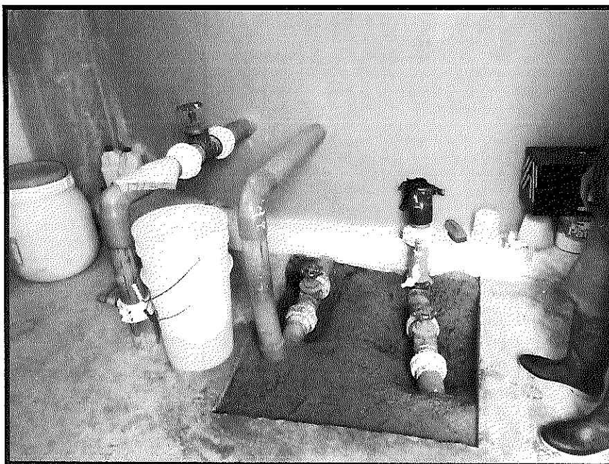
FOTOGRAFIA N° 6. VALVULAS DE OPERACIÓN Y MANANTENIMIENTO DEL RESERVORIO.
