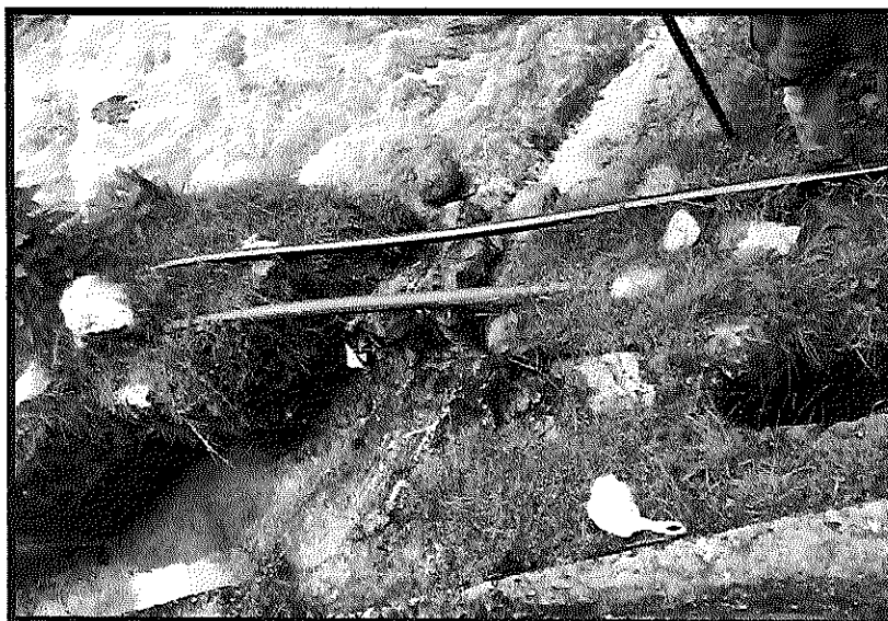
FOTOGRAFIA Nº 3. TUBERIA DE LINEA DE CONDUCCION EXISTENTE EXPUESTAS AL MEDIO AMBIENTE.
