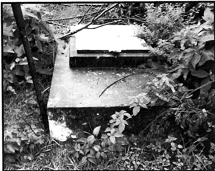
FOTOGRAFIA N° 11. CAMARA ROMPE PRESION FUERA DE FUNCIONAMIENTO.
