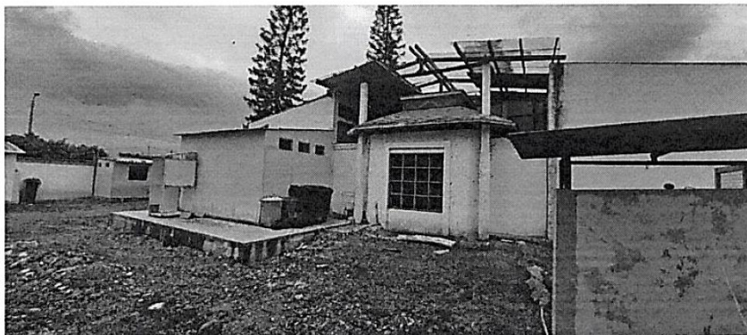
Foto 1: Parte posterior del establecimiento de salud donde la cobertura se encuentra en mal estado. Se proyectarán los voladizos a fin de evitar el escurrimiento en muros.
