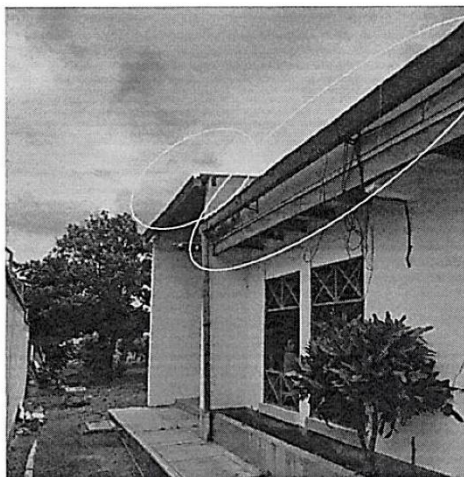
Foto 2: Se proyectarán los voladizos a fin de evitar el escurrimiento en muros
