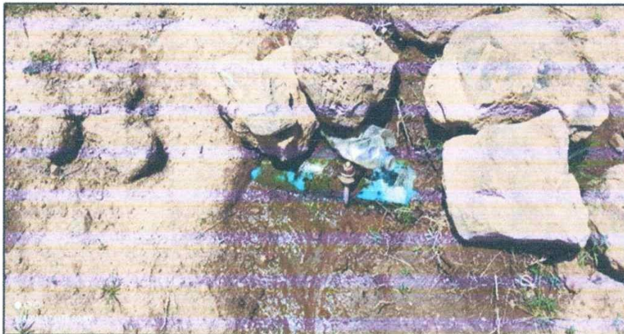
ILUSTRACIÓN 6: FILTRACIÓN DE AGUA EN EMPALMES EN LÍNEA DE CONDUCCIÓN
