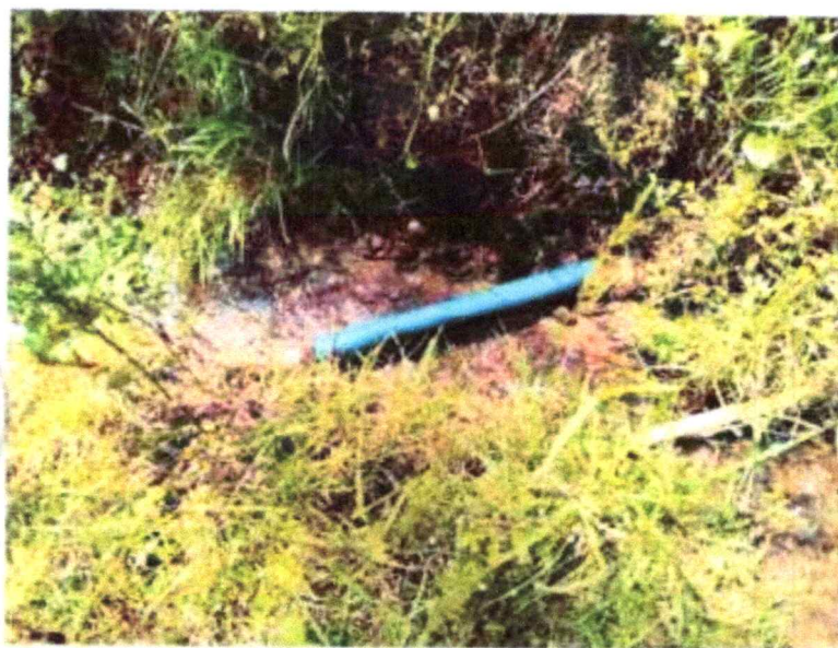
IMAGEN N° 04: Tramo de red de conducción actual de HDP, expuesto a la intemperie (cerca pasea aéreo)
