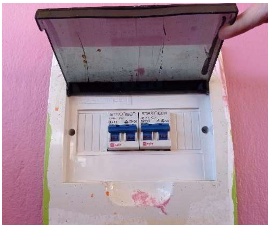
Fotografía 16: Vista del Tablero de distribución existente en el interior del aula 01.
