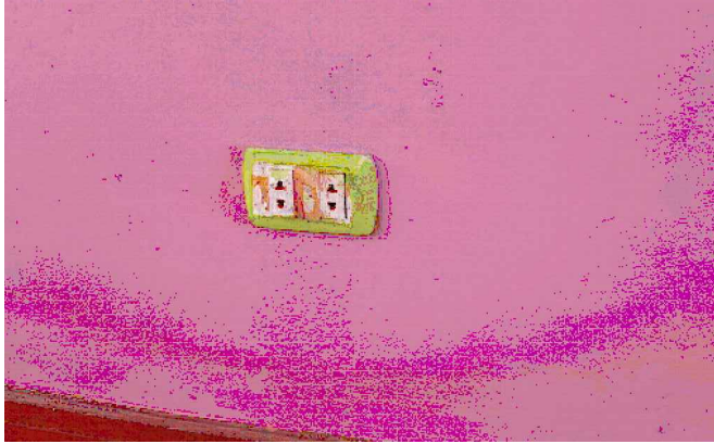
TOMACORRIENTES: tipo doble sin toma a tierra en estado regular.
