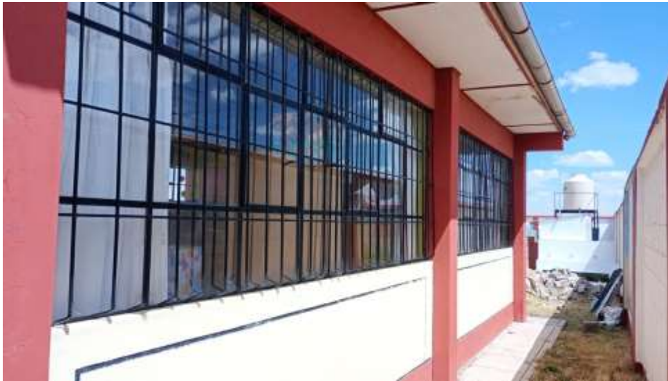
Fotografía 05: Vista en perspectiva de la fachada posterior del aula 01, se aprecia las ventanas y rejas de protección de marcos de hierro con vidrio simple en regular estado de conservación y alero de triplay en mal estado de conservación.
