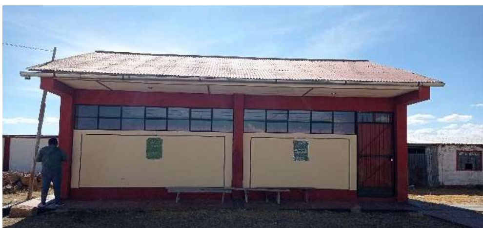
Fotografía 02: Vista principal del aula 01 en el módulo 1 del nivel inicial, se aprecia la edificación de albañilería confinada y techo de cobertura liviana de calamina en regular estado de conservación.
