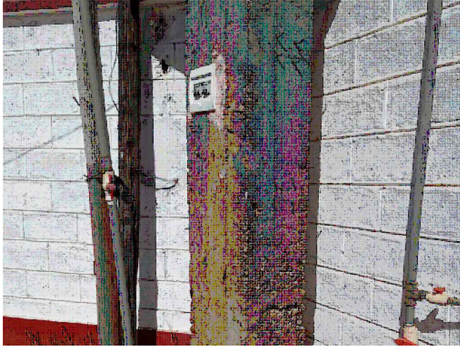
El Tablero general, se encuentra en empotrado en un columna en la parte exterior, es de PVC, con algunas llaves termomagnéticas, donde mediante cableado aéreo, distribuye la energía al resto de módulos.
