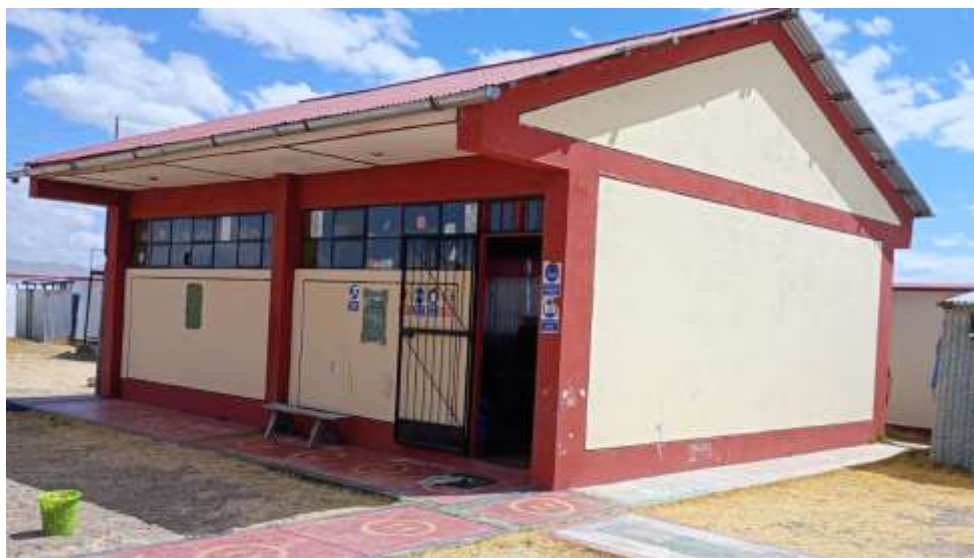
Fotografía 03: Vista en perspectiva del aula 1, se aprecia la fachada de la parte frontal y lateral derecho, asimismo las puertas de madera y de rejas de protección, las ventanas con ángulos metálicos y vidrio simple, canaleta metálica los que se encuentran en regular estado de conservación y el falso cielo raso en aleros se encuentran en mal estado de conservación.
