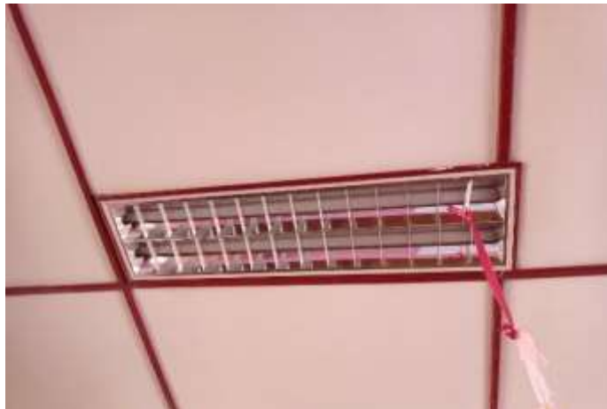
Fotografía 11: Vista en el interior del aula, se aprecia la luminaria empotrada en el cielo raso de triplay en regular estado de conservación.
