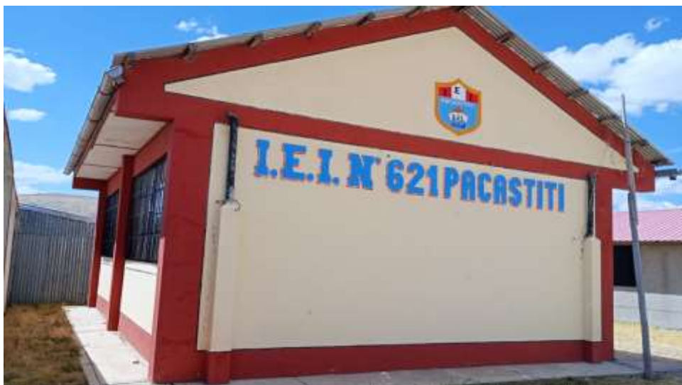
Fotografía 04: Vista en perspectiva del aula 01, se aprecia la fachada lateral izquierda y posterior, asimismo los muros de albañilería confinada con columnas y vigas laterales de concreto, con cobertura de calamina metálica, canaleta metálica en regular estado de conservación y falso cielo raso en aleros se encuentran en mal estado de conservación.
