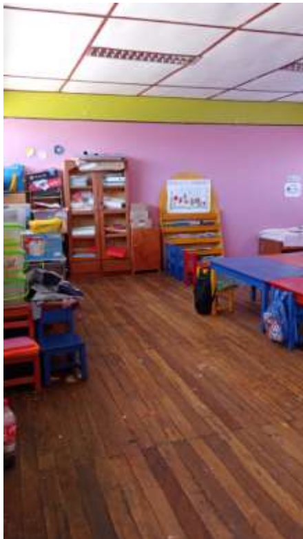
Fotografía 09 y 10: Vista interior del aula 1, se aprecia el piso de madera en deterioro, con apertura entre tablones y desniveles.
