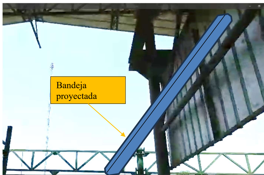
Figura 10. Ubicación de bandeja proyectada con conexión a bandeja existente.
