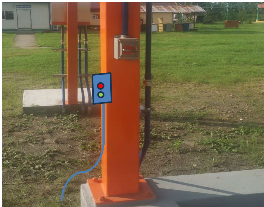
Imagen 9. Ubicación proyectada de botonera de arranque manual Start/Stop. En la columna mas cercana a la electrobomba.
