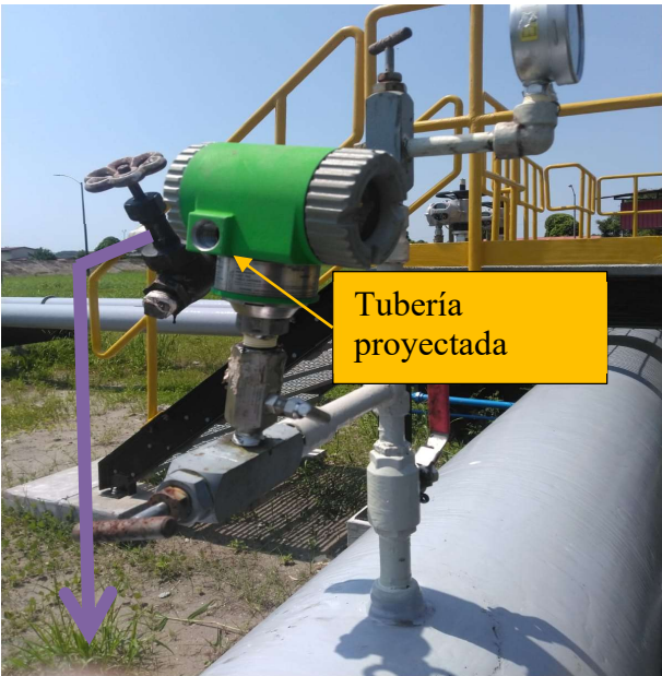
Figura 5. Transmisor de presión actualmente sin conexión eléctrica.
