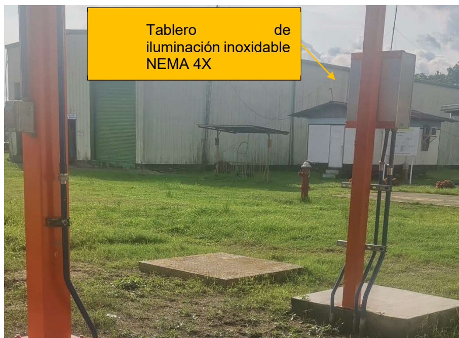
Imagen 7. Tablero de iluminación existente y disponible para adecuación.
