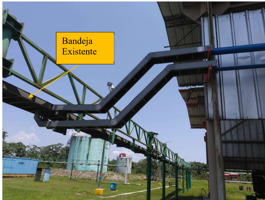
Imagen 6. Bandeja existente a emplear, para tendido de cable de acometida.
