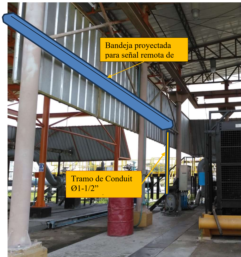
Figura 16. Proyección para instalación de bandeja portacable.
