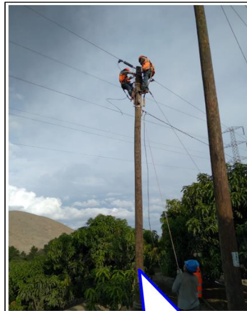
Figura N° 05 Poste de media tensión deteriorados, incumpliendo DMS
