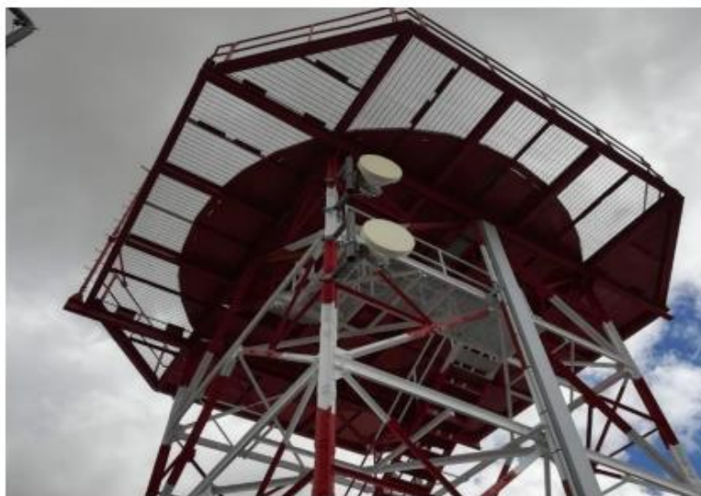
FIGURA 01 y 02 | Estructura de soporte de la Antena Radar
