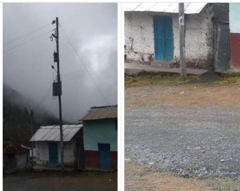
Estructuras en el AMT A4509, requieren su mejoramiento, por cumplir vida útil o incumplimiento de DMS
