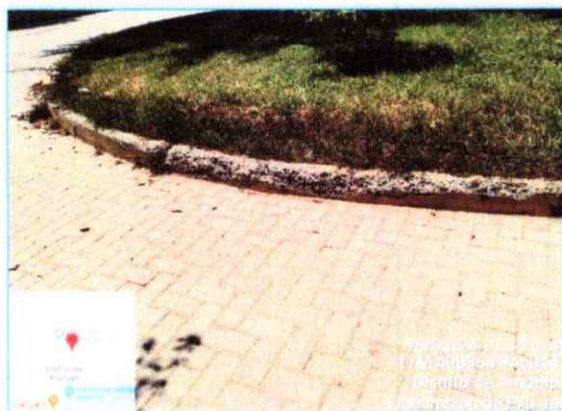
Fotografía N°02: Sardinel peraltado en estado de deterioro, por lo que se propone su demolición y reposición del mismo, según detalle de planos
