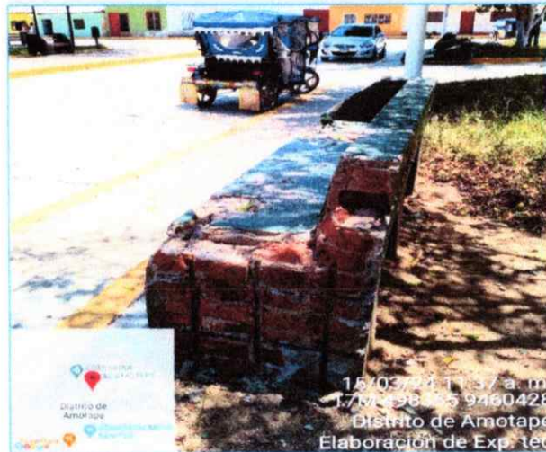
Fotografía N°03: Bancas existentes construidas de material de ladrillo, se encuentran en estado de deterioro, por lo que se propone su demolición.
