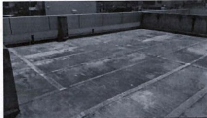
Foto 2: Impermeabilización De Techos (Asfalto Líquido) 4TO PISO
