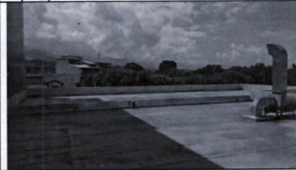
Foto 6: Impermeabilización De Techos (Asfalto Líquido) 4TO PISO
