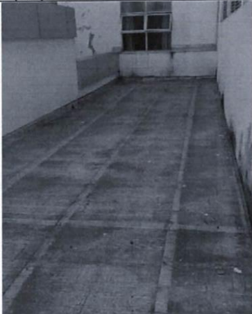
Foto 3: Impermeabilización De Techos (Asfalto Líquido) 3ER PISO
