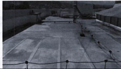
Foto 8: Impermeabilización De Techos (Asfalto Líquido) 4TO PISO
