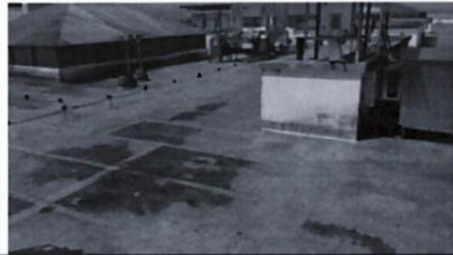
Foto 7: Impermeabilización De Techos (Asfalto Líquido) 4TO PISO
