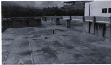
Foto 1: Impermeabilización De Techos (Asfalto Líquido) 4 TO PISO
