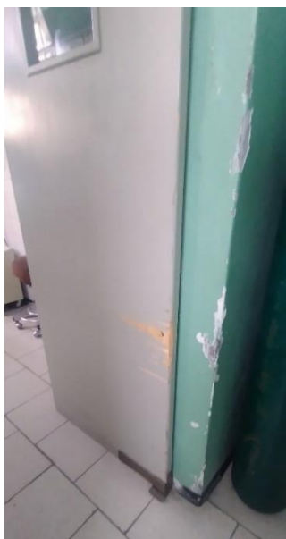
PUERTAS DE MADERA COMPLETAMENTE DETERIORADAS
