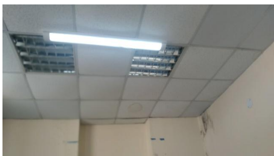
BALDOSAS PRESENTAN DEFORMACIÓN, MANCHAS EN SALA DE RECUPERACIÓN
