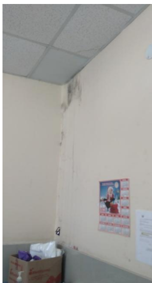
DESPRENDIMIENTO DE PINTURA EN SALA DE RECUPERACION
