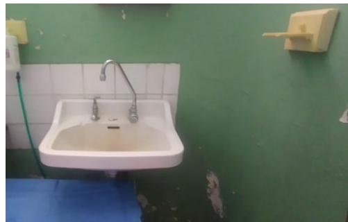
LAVADOS DE MANOS QUIRURGICO Y DE CERAMICA DETERIORADOS
