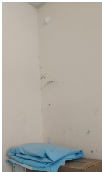
DESPRENDIMIENTO DE PINTURA EN SALA DE RECUPERACION
