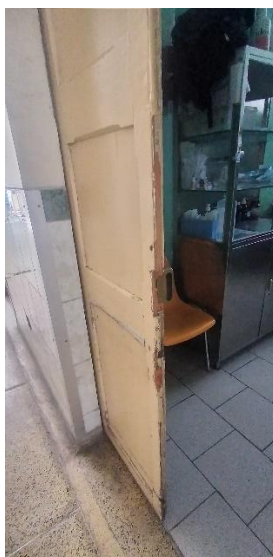
PUERTAS DE MADERA COMPLETAMENTE DETERIORADAS
