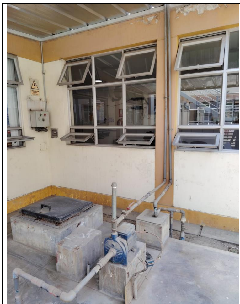
Foto 10. Se visualiza en mal estado la electrobomba
