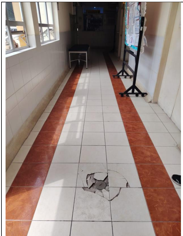
Foto 4. Se visualiza la mayólica dañada en el pasadizo.
