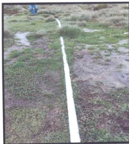
FOTOGRAFIA N° 7 – FALTA ENTERRAR LA TUBERIA DE PVC DE 2" EXPUESTA.
