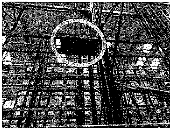
Imagen N° 01 y 02: Se aprecia la última viga y la plancha, el cual se apoyan en las vigas
