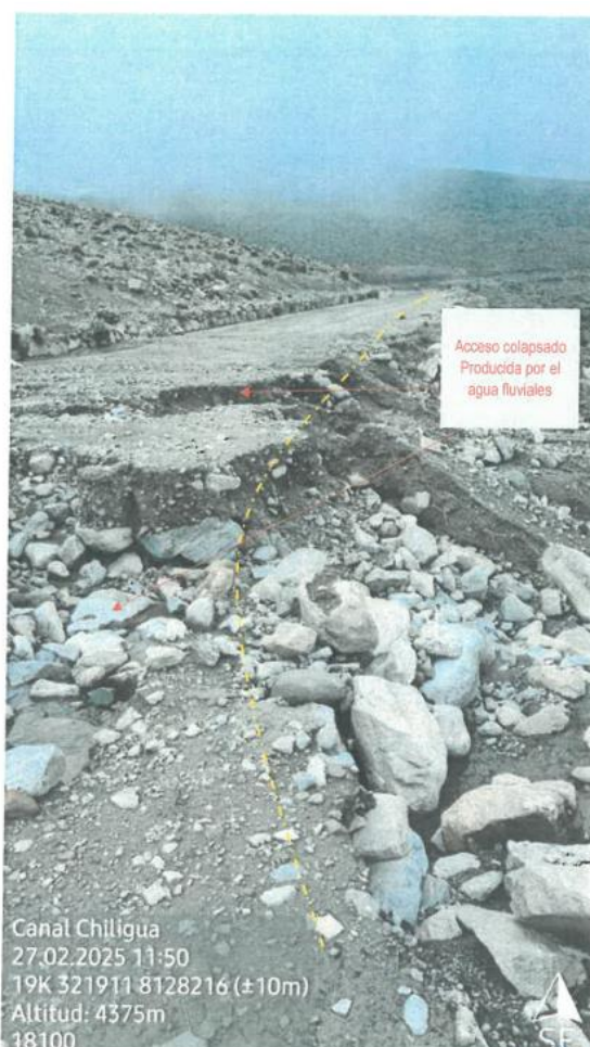
IMAGEN 30: Situación actual derrumbes Acceso colapsado
