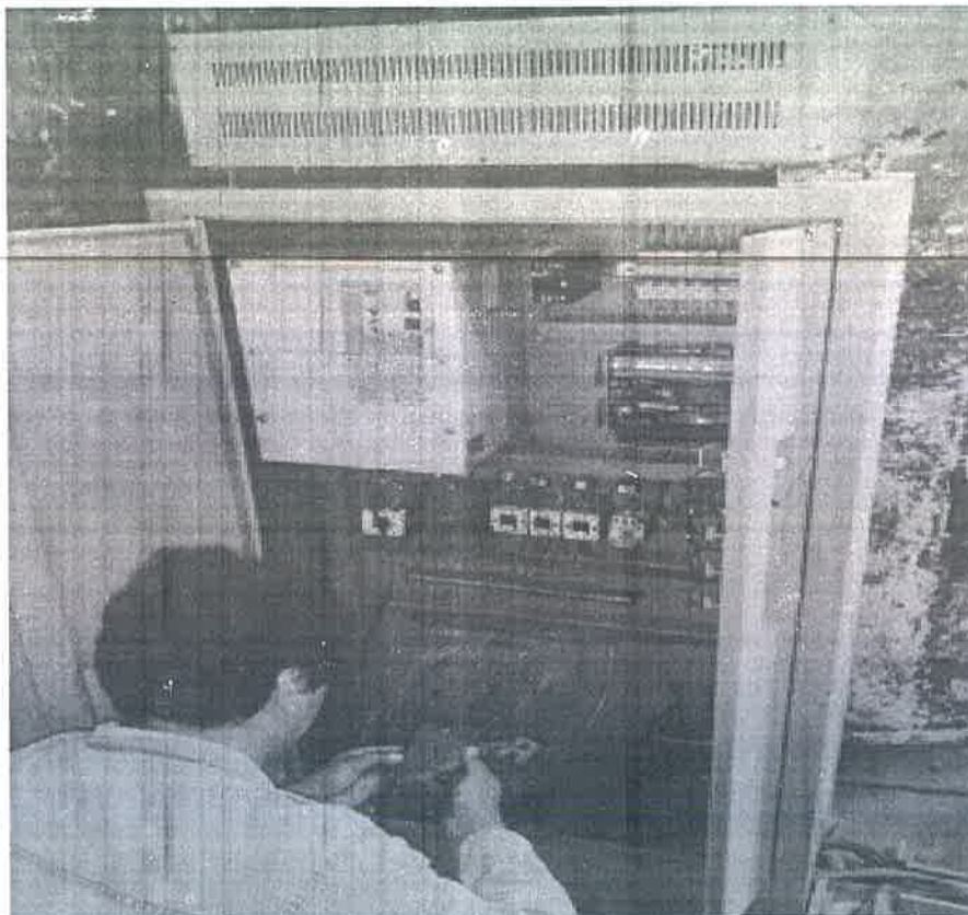
CUARTO DE MAQUINAS: TABLERO ELECTICO Y CONTROL.
