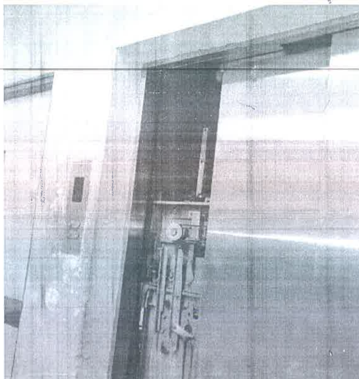
CABINA: SENSOR CORTINA LED PARA APERTURA Y CIERRE DE PUERTA.
