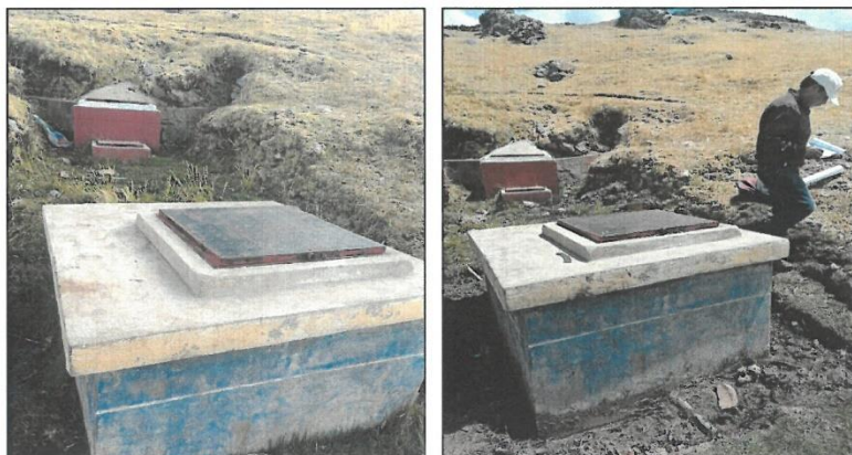
IMAGEN N° 05, 06 – CAMARA DISTRIBUIDORA DE CAUDALES
