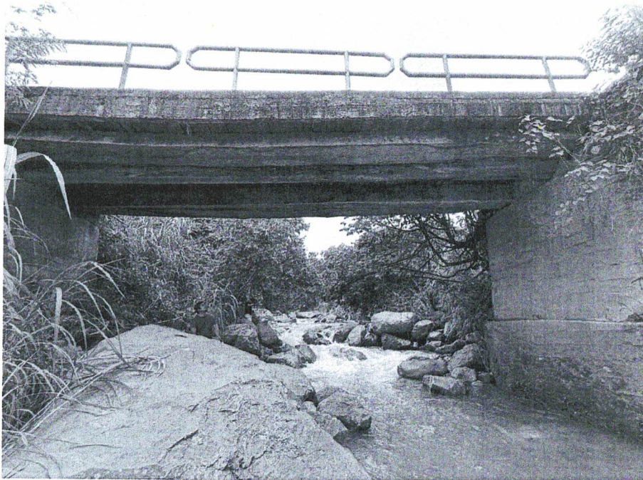
Figura 06: Vista del cauce debajo del puente existente. Vigas principales de material madera, la cual se observan pandeadas por la carga misma del puente y los vehículos que transitan por medio de este.
