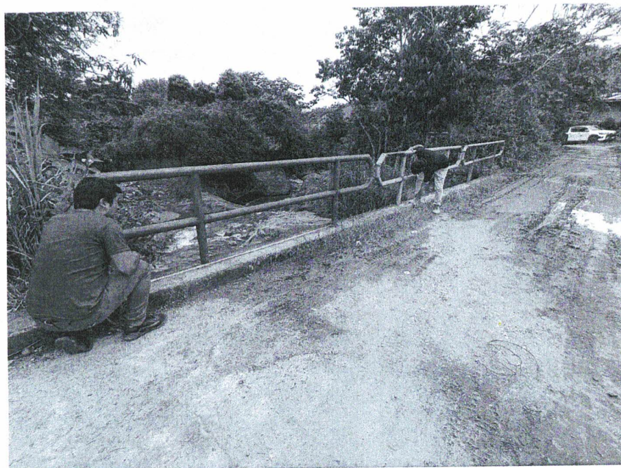
Figura 08: Puente Pangoya revisión de la superestructura, tomando medida de la luz total, se observa que cuenta con barandas metálicas.
