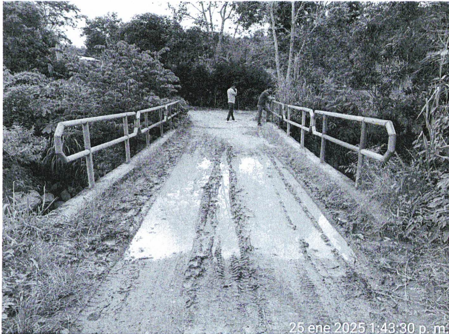
Figura 05: Puente existente vista superior de la losa, empozada de agua de lluvias, no cuenta con un adecuado sistema de dren.
