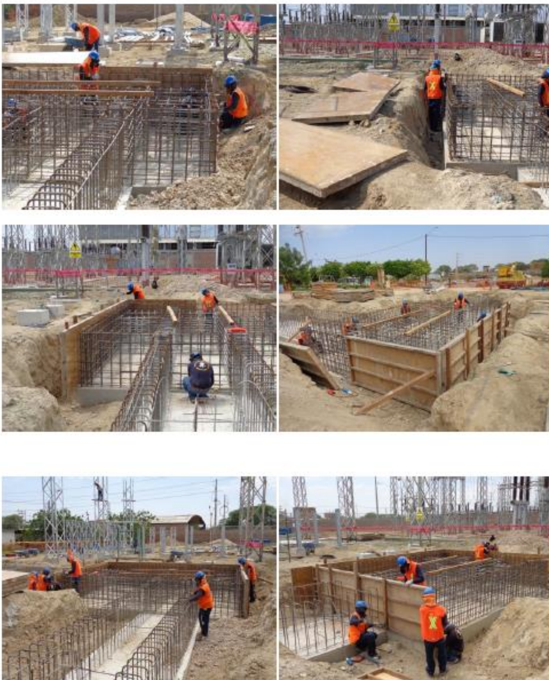
Colocación de encofrados de muros (una cara) para bases del Transformador de Potencia
