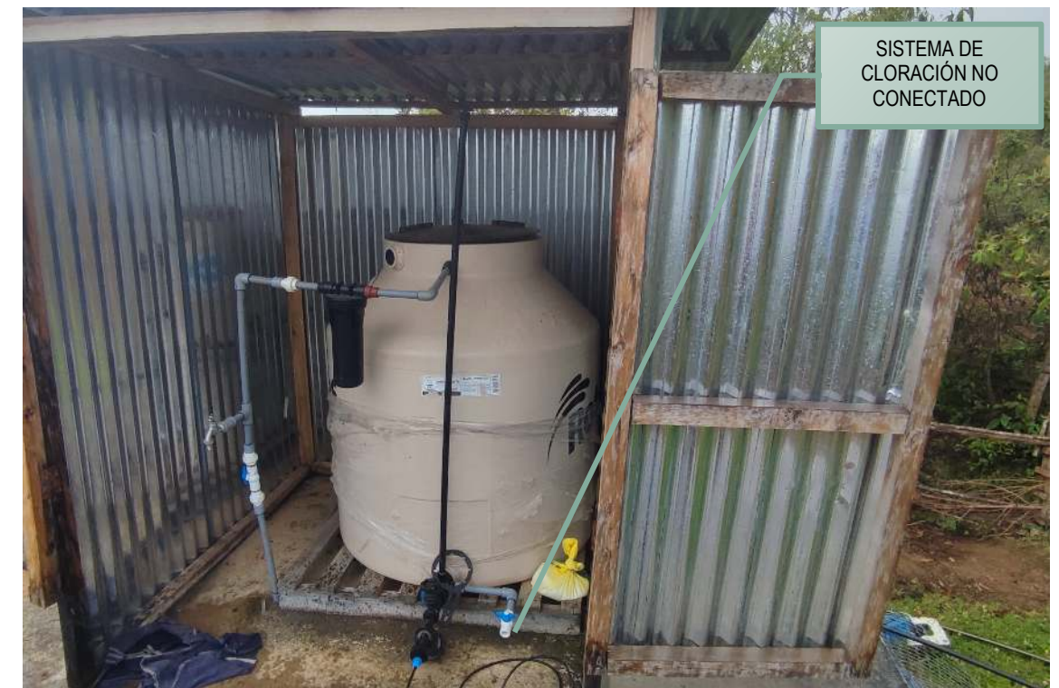
Foto N° 11: Sistema de Cloración del Reservorio de V=8.0m^3 – CC.PP. Colpapampa
