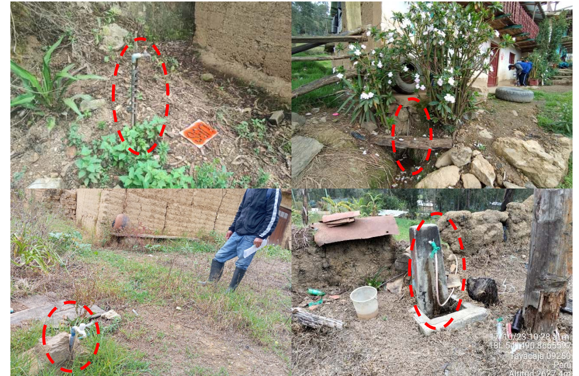
Foto N° 16: En la toma fotográfica se puede observar conexiones domiciliarias construidos empíricamente - CC.PP. Colpapampa
