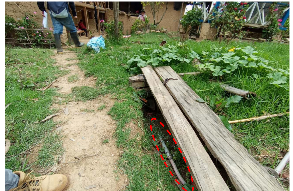
Foto N° 14: Se observa las redes de distribución instalados superficialmente, con riesgo a sufrir roturas – CC.PP. Colpapampa
