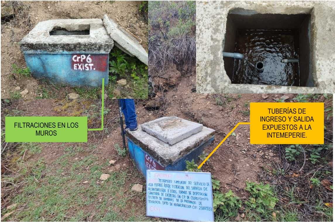
Foto N  9: C mara Rompe Presi n Tipo 06 – CC.PP. Colpapampa.
