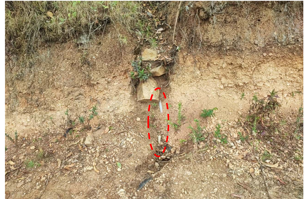
Foto N° 13: Se observa las redes de distribución instalados superficialmente, con riesgo a sufrir roturas – CC.PP. Colpapampa
