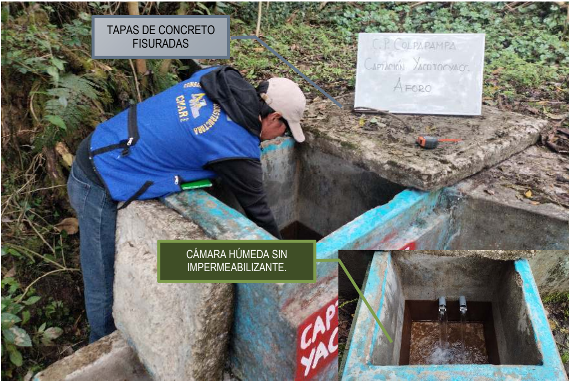
Foto N° 6: Estado situacional de la Captación Yacotocyacc – CC.PP. Colpapampa.
