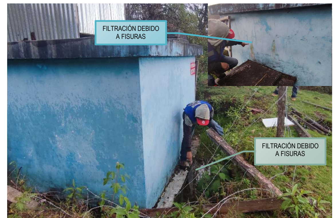
Foto N° 12: Fallas Estructurales del Reservorio de V=8.0m^3 – CC.PP. Colpapampa
