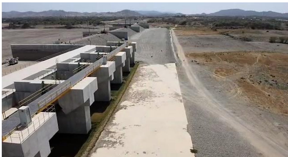
Foto N° 02.- Vista aérea aguas abajo de la tramo 3 y 4 de los diques fusibles del Aliviadero de Emergencia de la Presa Poechos, superficies secas.
