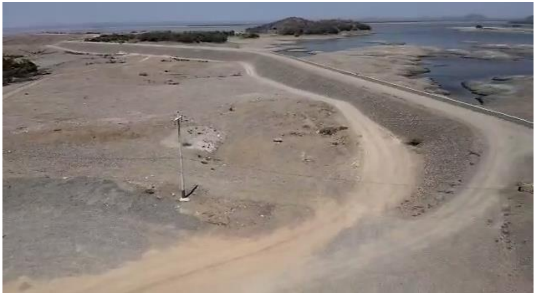
Foto N° 03.- Vista aérea instalación de grava tipo filtro invertido en el Tramo 2+800 a 2+950, del dique izquierdo, a la fecha se verifica superficie seca del blanket invertido.
