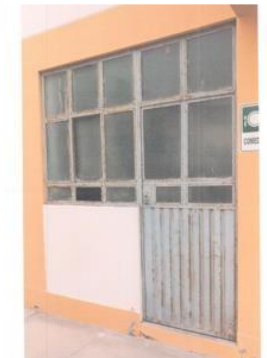
F6: Vista de puerta y ventana metálicas típicas a tener mantenimiento de pintura
