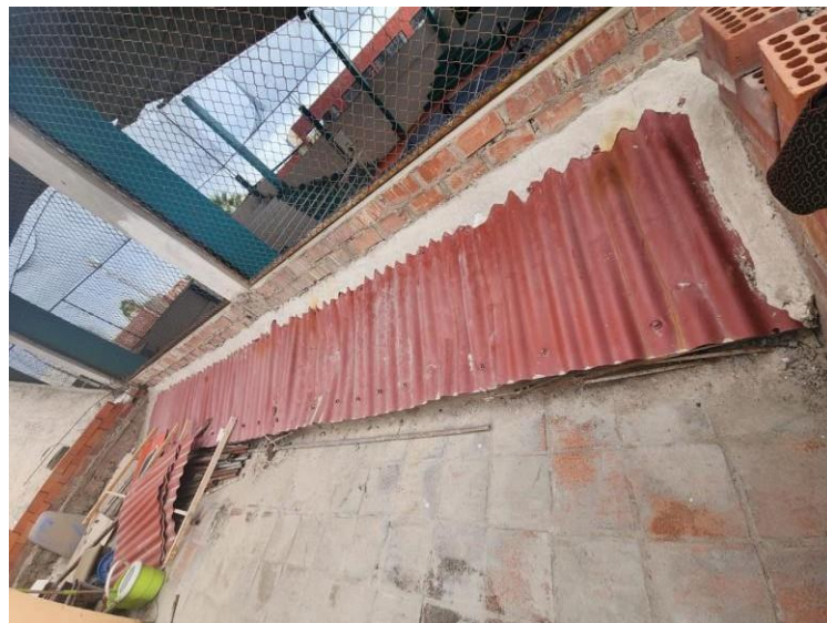
F4: Desmontaje e instalación de cobertura tipo TR4 con canaleta pluvial.
