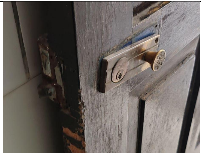
F5: Reposicion de cerrojos en mal estado
